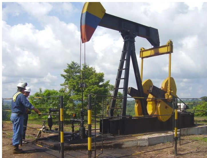
Figura 3. Sistema de extracción existente en campo escuela Colorado
