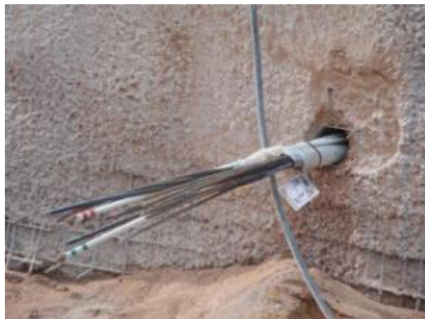
Figura 22. Tendón Ubicado En La Perforación.
