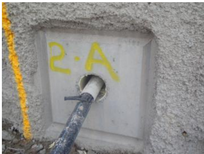
Figura 27. Base En Concreto Terminada.
