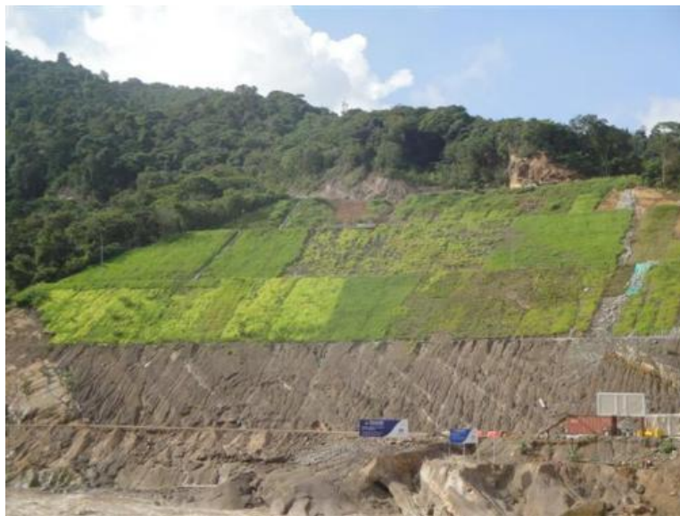
Figura 44. Talud Tratado Con Empradización.
