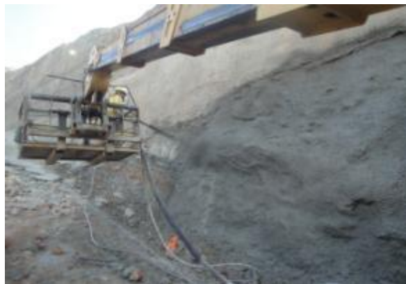
Figura 7. Primera Capa De Concreto Lanzado.
