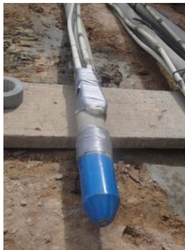
Figura 25. Detalles Del Tendón, Tapa Metálica – Tubo De Reinyección.
