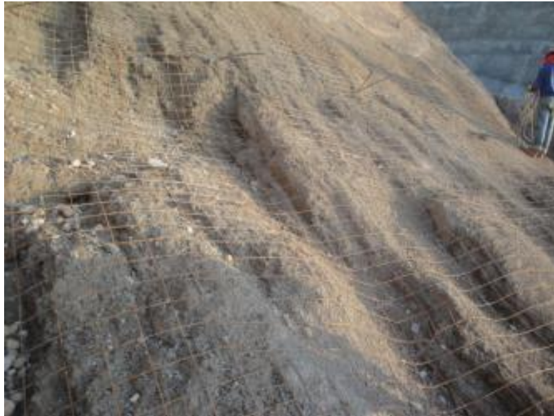
Figura 10. Colocación De La Malla Electro-Soldada.
