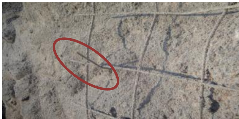
Figura 5. Clavijas Para Asegurar La Malla De Refuerzo.
