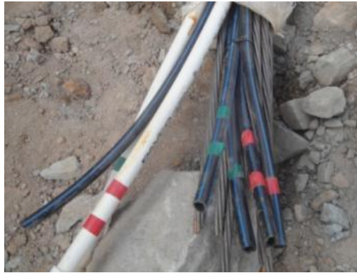
Figura 23. Detalle De Las Mangueras De Inyección.
