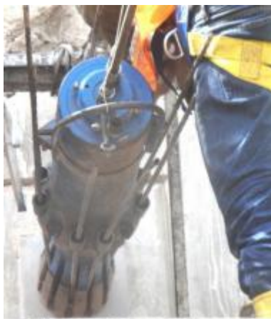
Figura 29. Tensionamiento Con Gato Hidráulico.
