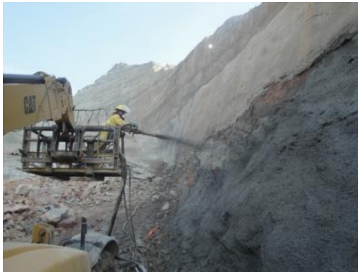
Figura 2. Talud Revestido En Concreto Lanzado.
