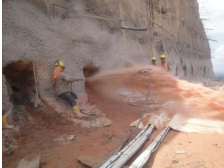
Figura 20. Limpieza De La Perforación Con Agua A Presión.
