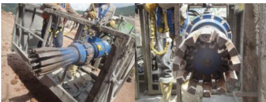
Figura 28. Detalle Del Gato Hidráulico.
