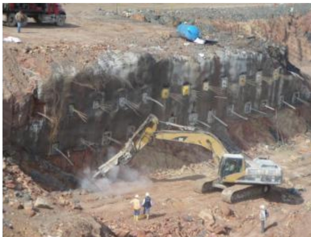
Figura 14. Perfilación Del Talud.
