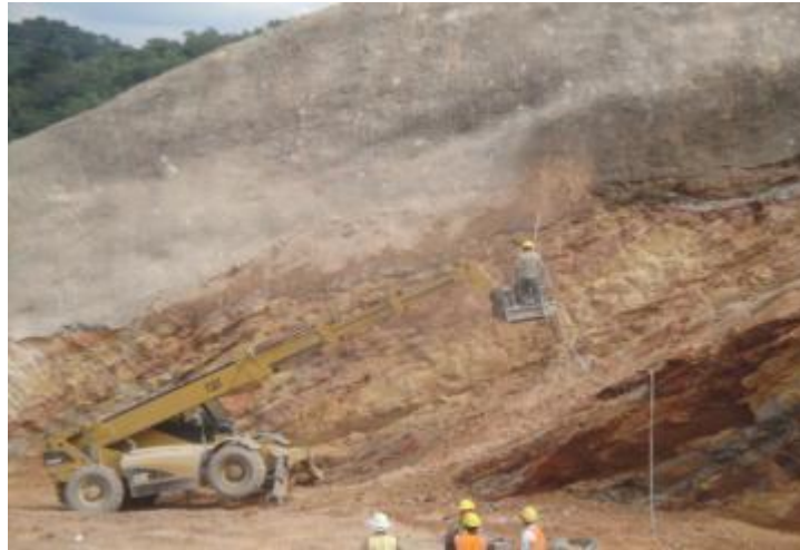
Figura 4. Limpieza Con Chorros De Agua.
