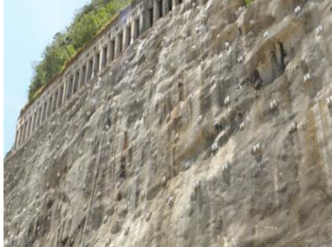
Figura 12. Talud Contenido Con Tendones De Anclaje.
