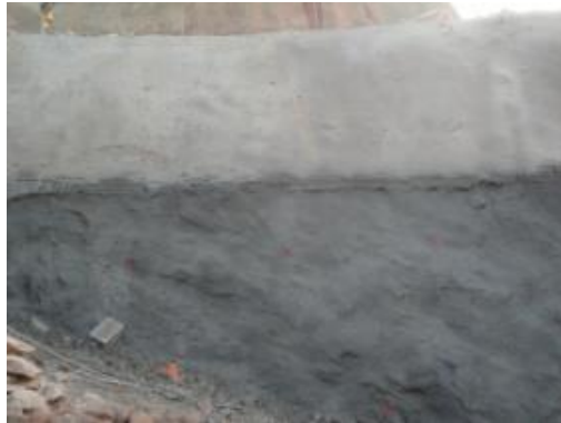
Figura 8. Concreto Lanzado Según Etapas De Excavación.
