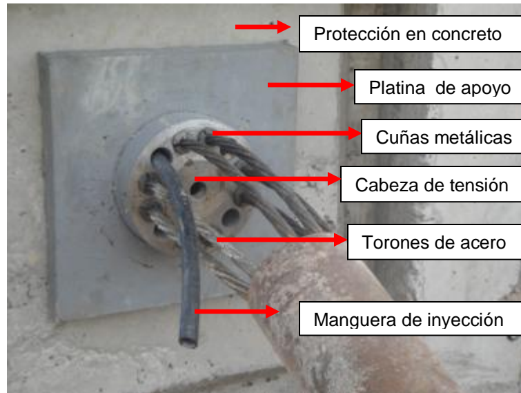
Figura 13. Elementos Del Cabezote En Los Tendones De Anclaje.
