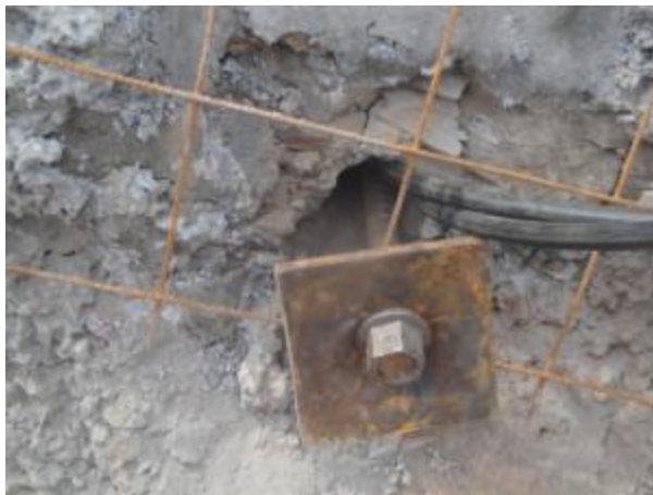
Figura 42. Detalle De La Platina Del Perno.
