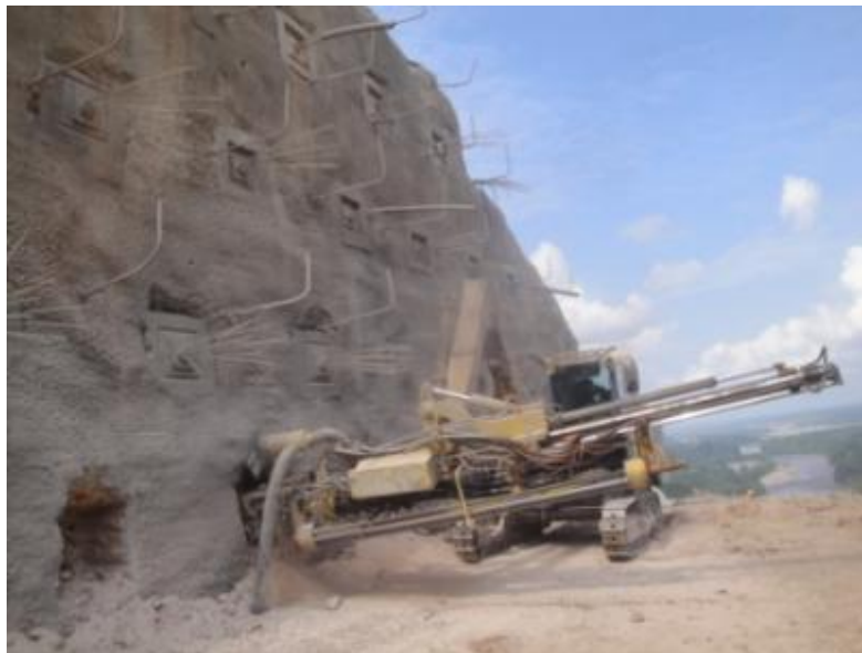
Figura 15. Proceso De Perforación Para Tendones.
