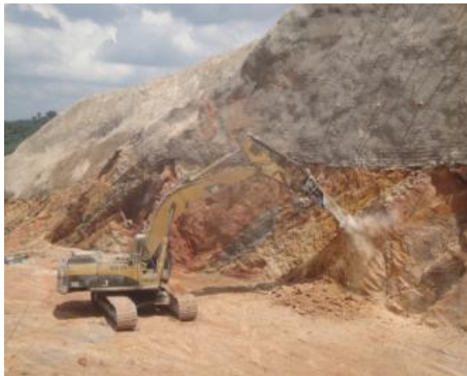
Figura 3. Perfilación Del Talud.
