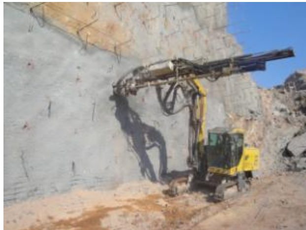
Figura 38. Maquinaria Utilizada Para La Perforación
