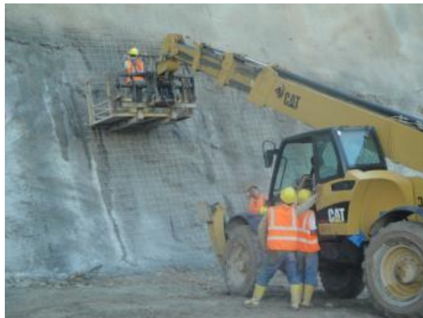
Figura 9. Colocación De La Malla Electro-Soldada.
