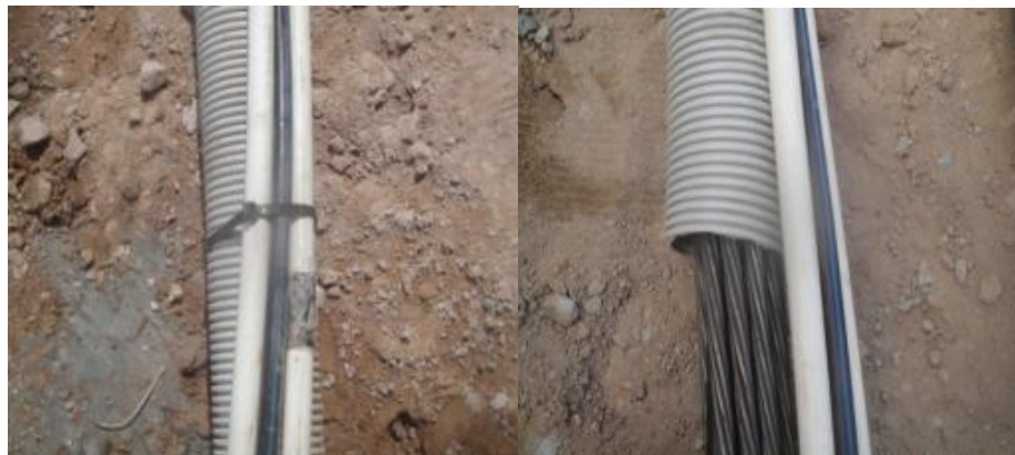
Figura 24. Detalle De Las Mangueras De Inyección.
