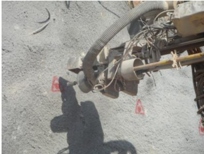
Figura 39. Perforación Para Instalación De Pernos
