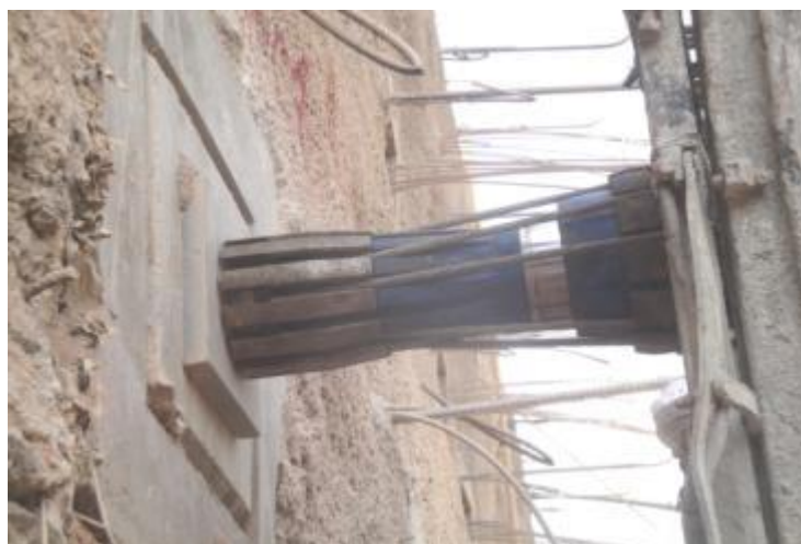
Figura 30. Tensionamiento Con Gato Hidráulico.
