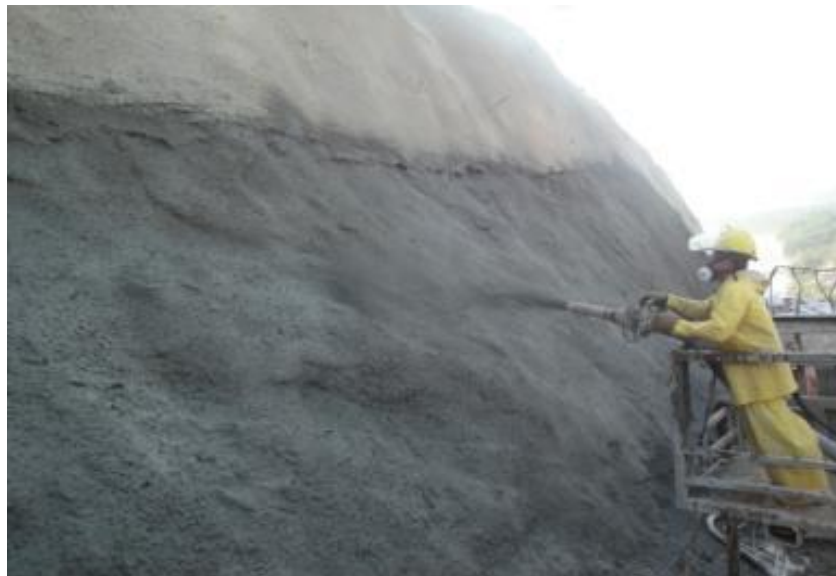
Figura 11. Segunda Capa De Concreto Lanzado.
