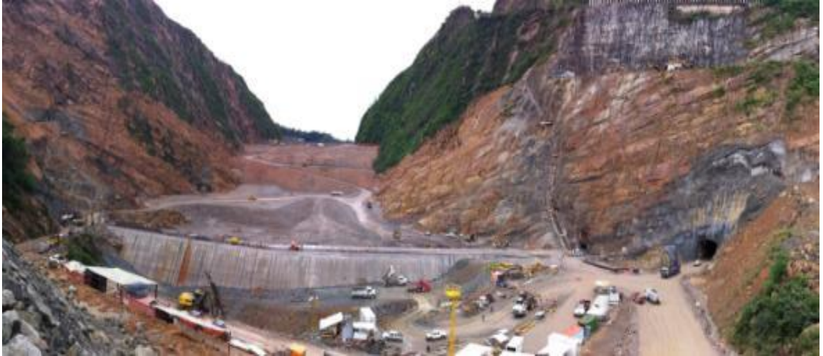
Figura 1. Construcción Del Proyecto Sogamoso
