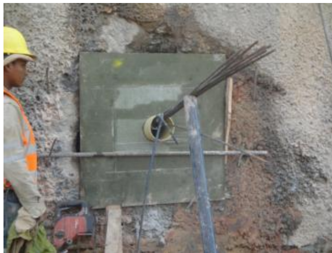
Figura 26. Formaleta Para La Base En Concreto.
