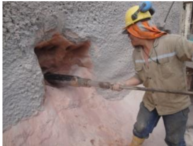
Figura 18. Introducción Del Obturador.
