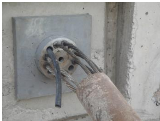
Figura 32. Tendón Instalado
