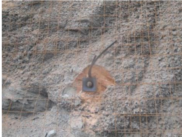
Figura 41. Perno Lista Para Ser Inyectado.
