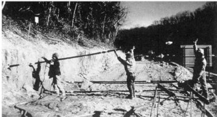
Ilustración 16: Excavación inicial e instalación del anclaje
