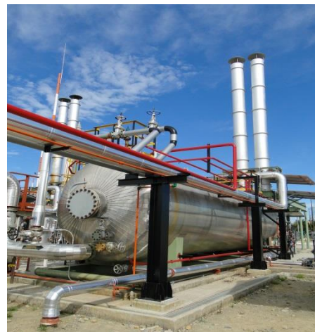
Imagen 6: Fotografías de los calandores de crudo - Estación Chichimene
