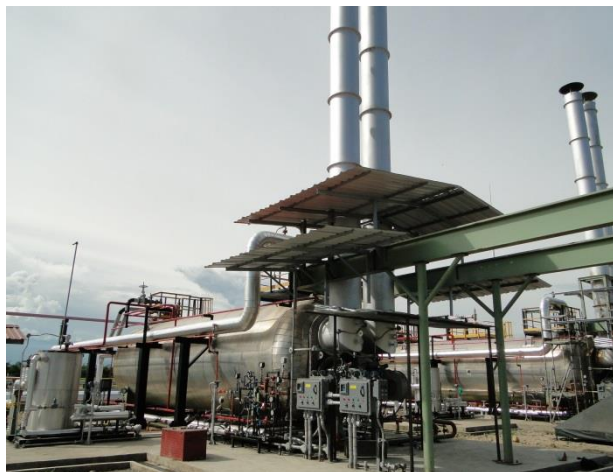
Imagen 6: Fotografías de los calandores de crudo - Estación Chichimene
