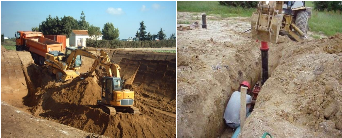
Fotografía 5. Excavaciones para Estructura y Tipo Zanja.
