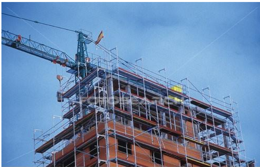
Fotografía 7. Construcción Tradicional en mampostería.
