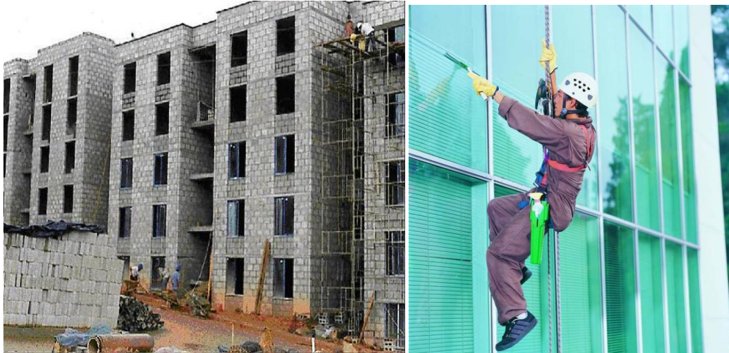
Fotografía 8. Edificio en Fase de Acabados.
