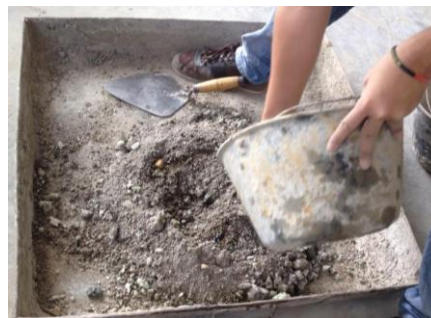
Figura 6. Añadiendo agua a la mezcla
