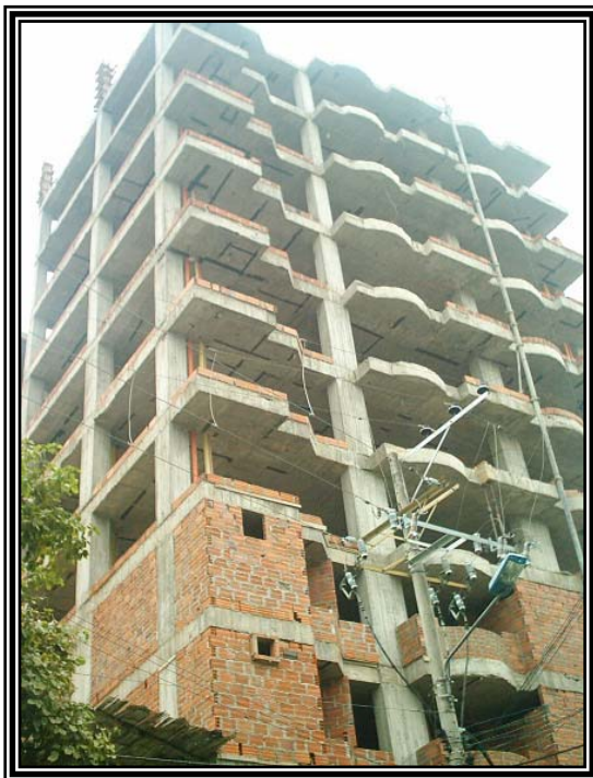
Figura (3.26) Foto Edificio Chiranue
