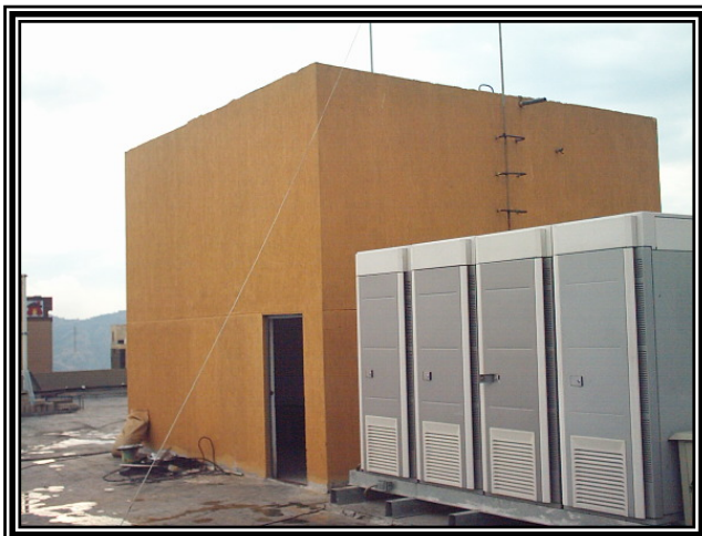
Figura (3.3) Foto Tanque Elevado Coopmagisterio
