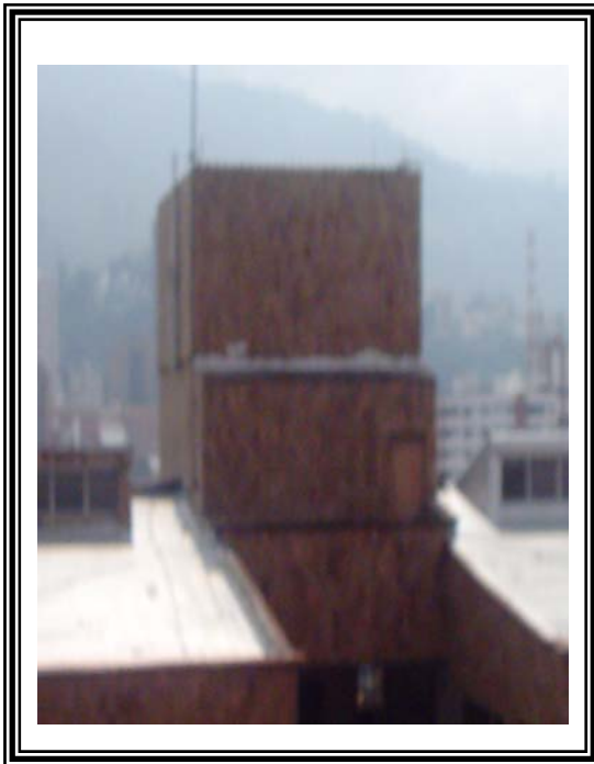
Figura (3.9). Foto Tanque EL Puente.
