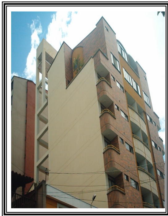
Figura (3.20) Foto Edificio Pozuelo de Alarcón
