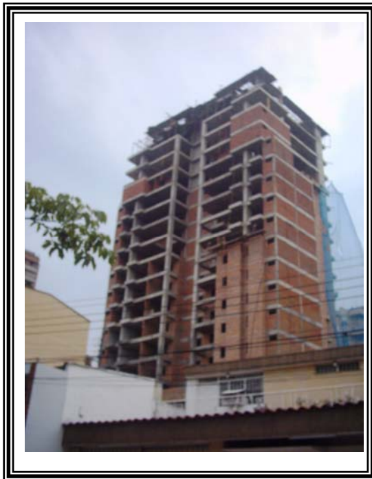
Figura (3.23) Foto Edificio Torreón
