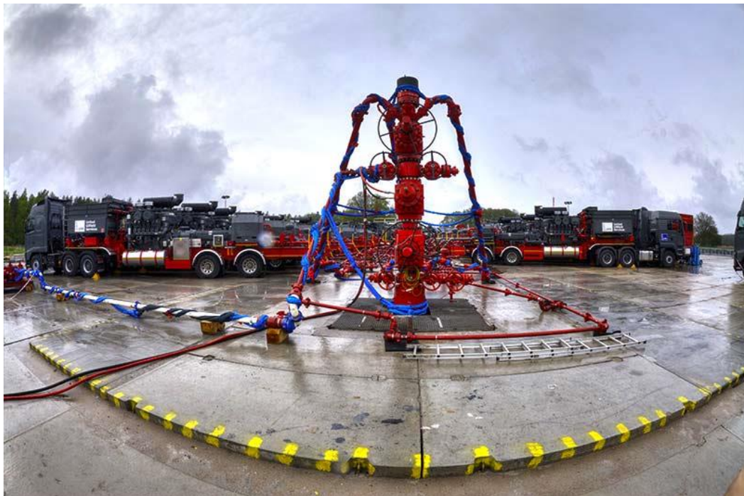
Figura 7. Cabeza de pozo durante fracturamiento hidráulico
