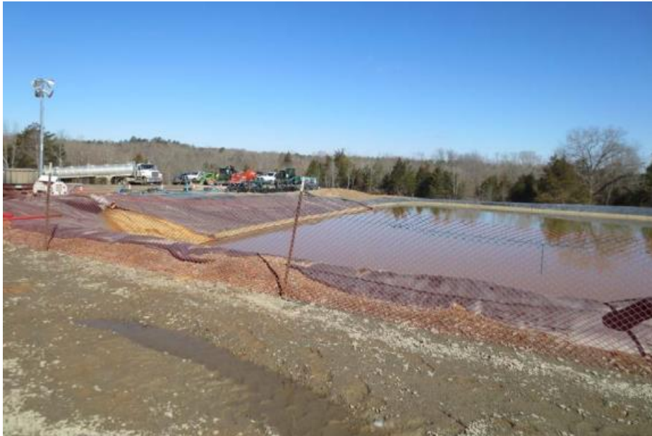
Figura 8. Piscina de desecho de una operación de fracturamiento hidráulico en Arkansas, EE.UU
