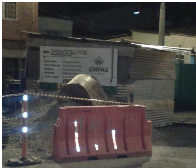
Figura 4. Campamento de obra civil. Bucaramanga.
