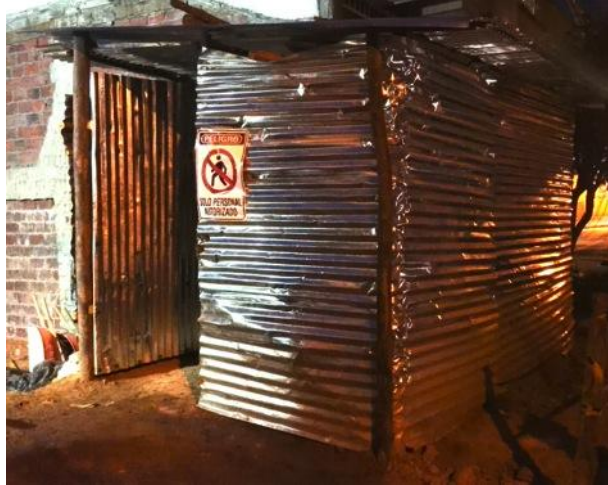
Figura 1. Campamento temporal en obra civil, Bucaramanga.
