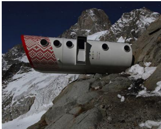
Figura 7. Leap Factory, construcción de campamento Italia, (LEAP, 2010).
