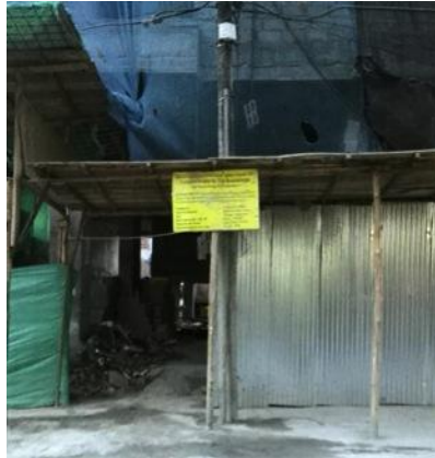
Figura 38. Caseta de obra, lámina de zinc y madera.
