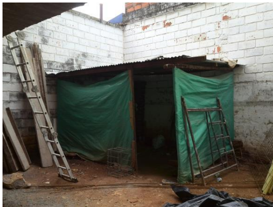
Figura 37. Caseta improvisada en madera, tejas y tela para cerramiento.
