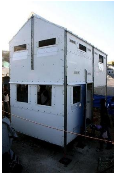
Figura 15. Albergue para petrolera de dos pisos. Shelter, 2011.
