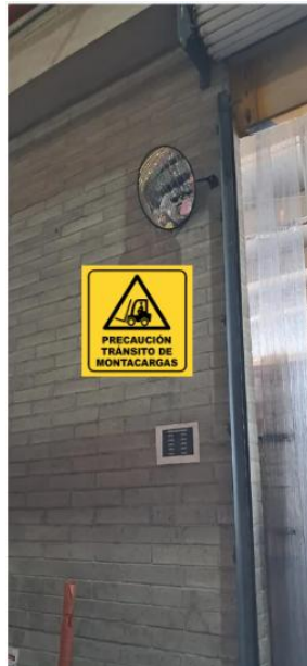
Figura 8. Señalización Preventiva de Circulación de Montacargas
