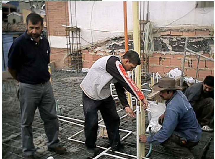
Figura 23. COLOCAR INSTALACIONES HIDRAULICAS
