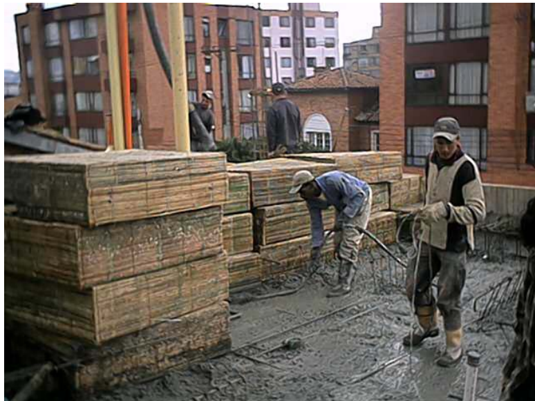
Figura 18. VIBRADO TORTA
