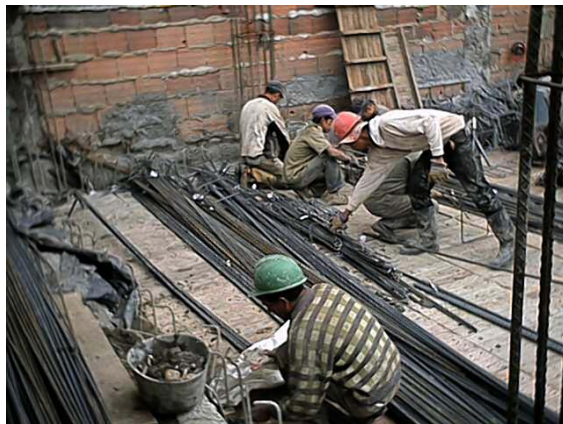
Figura 10. ALMACENAMIENTO Y ARMADA DE CAMA PARA LOSA
