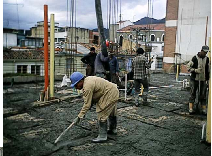
Figura 21. BOMBEO CONCRETO PARA VIGAS Y VIGUETAS
