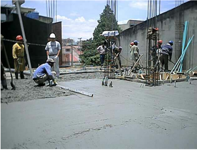
Figura 26. FUNDIDA Y NIVELACION TORTA SUPERIOR
