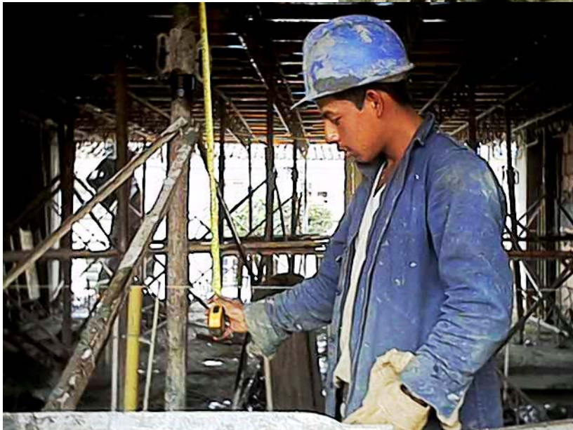
Figura 25. VERIFICACION DE NIVELES
