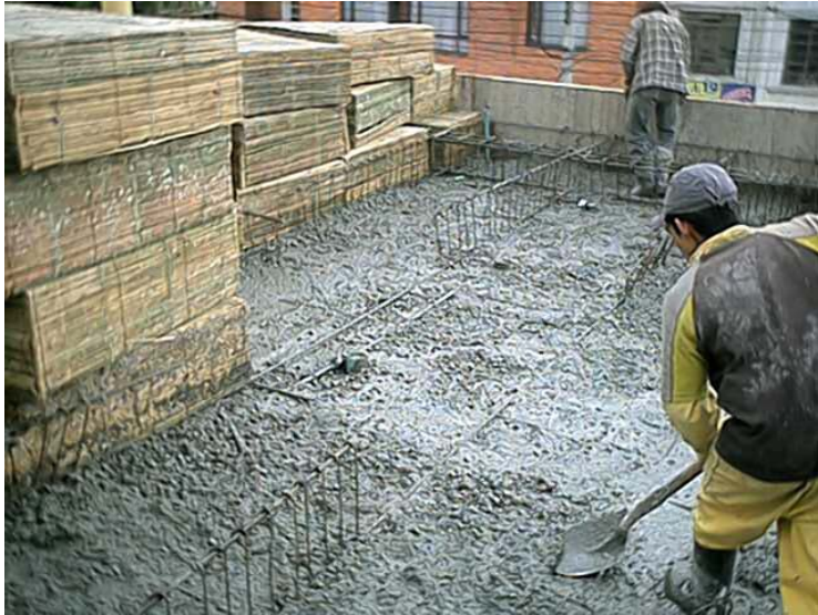
Figura 17. RETIRO DE CASETON Y FUNDIDA TORTA INFERIOR
