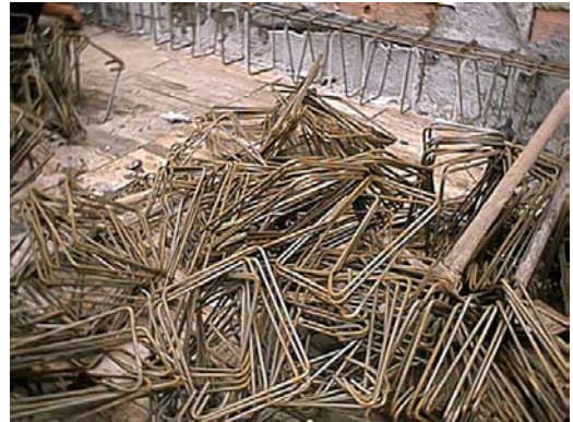
Figura 9. ALMACENAMIENTO DE HIERRO Y SELECCIÓN PARA CADA ELEMENTO
