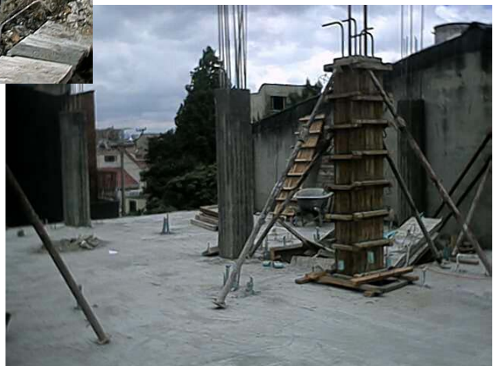
Figura 43. RENIVELAR Y TRANCAR PARA QUE MANTENGA SU POSICION VERTICAL
