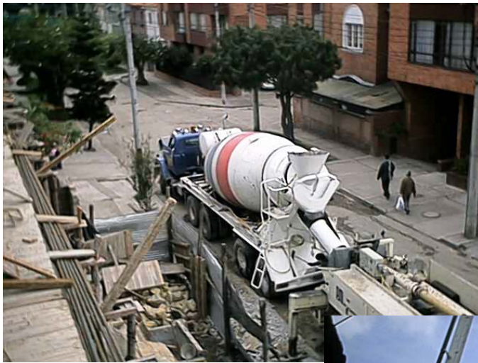
Figura 20. BOMBEO DE CONCRETO
