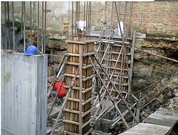
Figura 43. RENIVELAR Y TRANCAR PARA QUE MANTENGA SU POSICION VERTICAL
