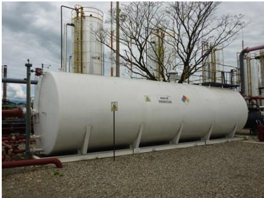
Figura 15. Tanque desnatador
