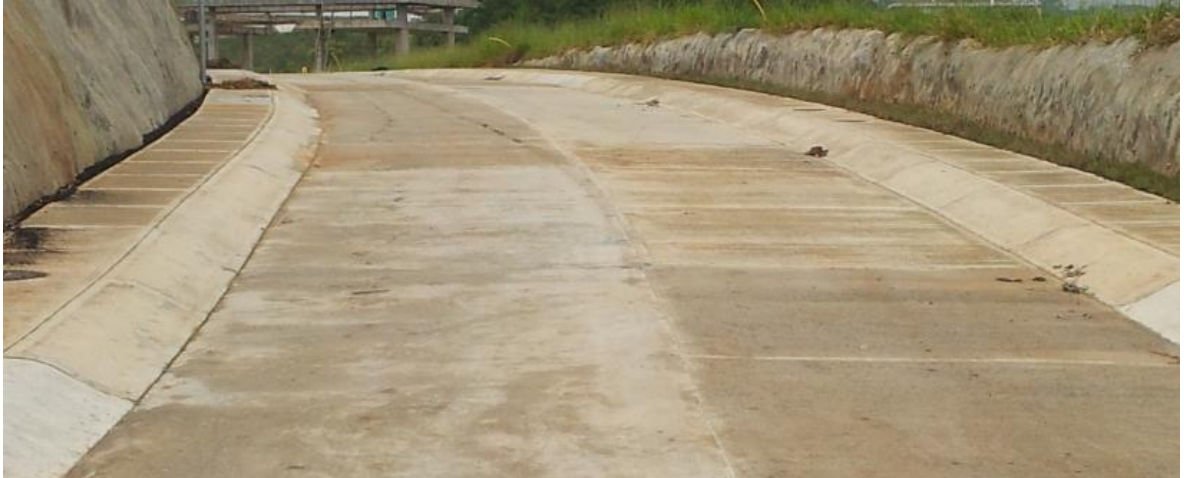
Figura 5. Vía en pavicreteo, andenes y sardineles tipo ruitoqueño.
