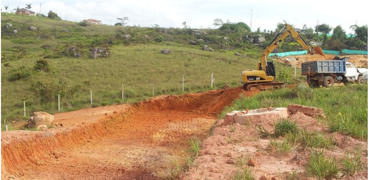
Figura 2. Movimiento de tierra
