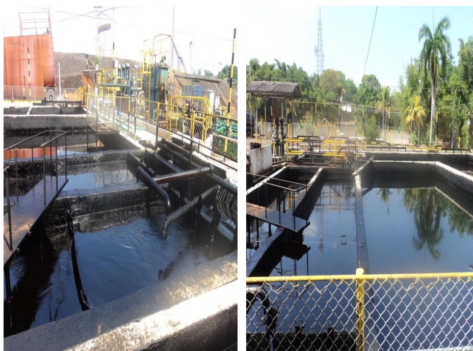
Fig.76 Piscinas API recolección de sistemas de drenaje
