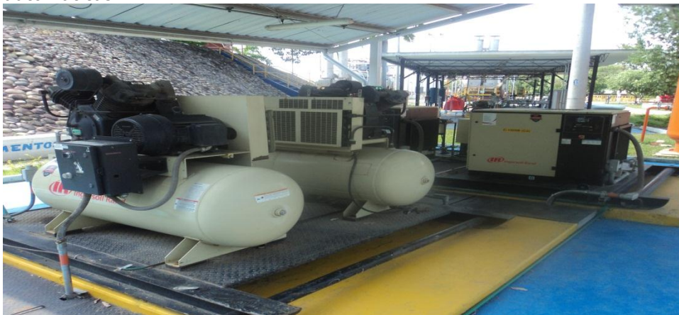
Fig.27 Sistema compresor de aire
