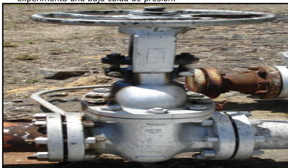
Fig.75 Válvula de compuerta
