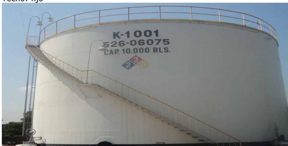
Fig.41 Tanque de reposo K-1001
