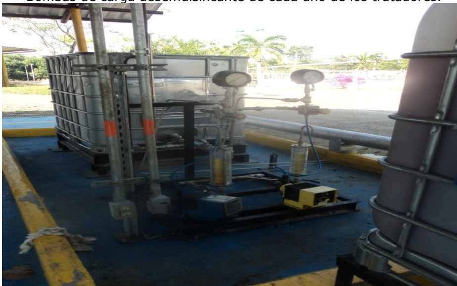
Fig.28 Sistema de inyección de químico desemulsificante
