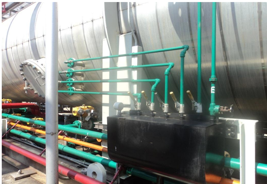
Fig.51 Toma muestras tratadores termoelectrostáticos
