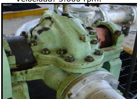
Fig. 54 Bombas Goulds modelo 3405
