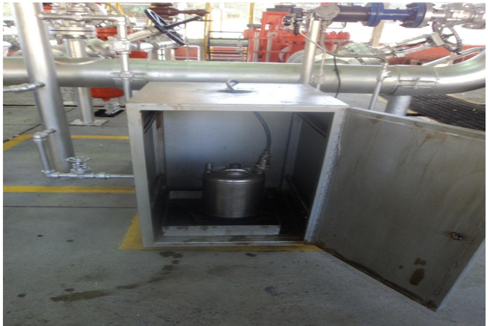
Fig.60 Sistema toma muestra automático
