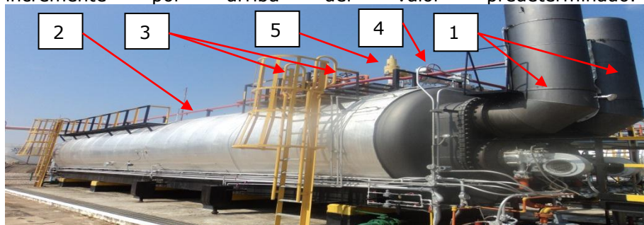
Fig.32 Sistema de gas producido
