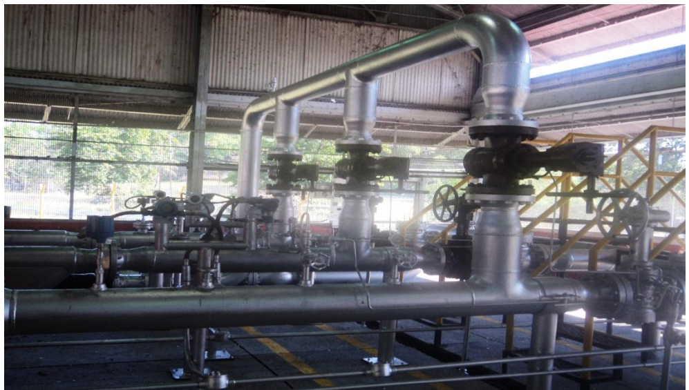
Fig.61 Arreglo de válvulas para el probador maestro del medidor
