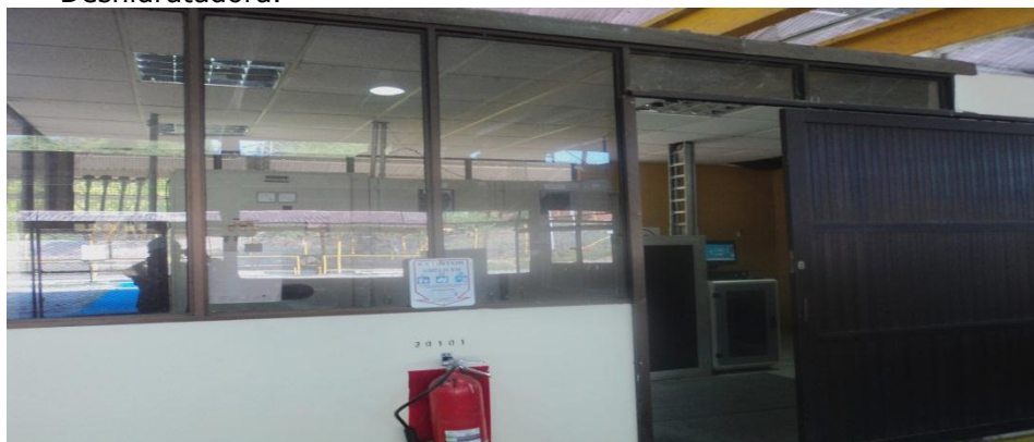
Fig.67 Caseta de control de la estación de bombeo
