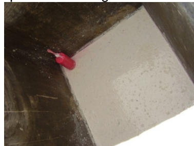
Figura 6. Interior contenedor para tratamiento especializado de grasas
