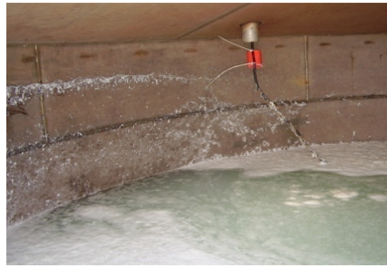
Figura 12. Controlador de nivel (Interior tanque 1)
