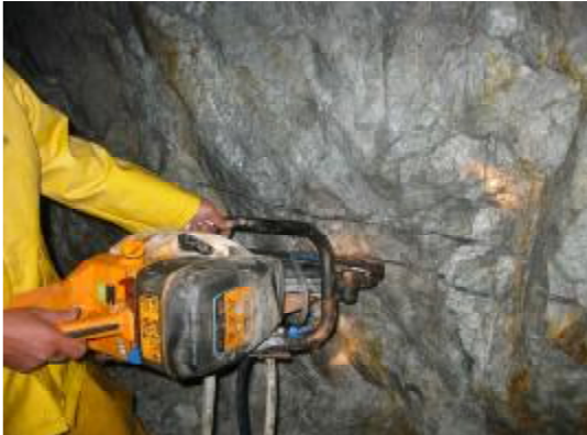
Figura 7. Muestras de canal Túnel la Perezosa
