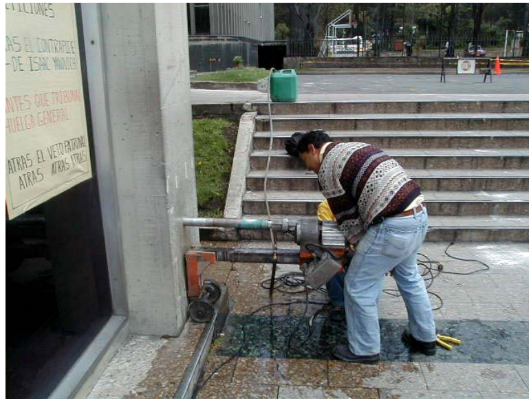
FIGURA 116. EXTRACCIÓN DEL NÚCLEO.
