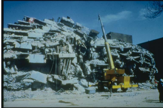
FIGURA 2. EJEMPLO DE DAÑOS EN EDIFICACIONES.
