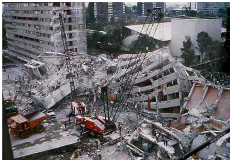
FIGURA 12. EJEMPLOS DE PATOLOGÍA POR CONFIGURACIÓN GEOMÉTRICA.
