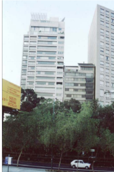
FIGURA 93. SEPARACIÓN ENTRE EDIFICIOS DE DIFERENTE ALTURA CON SEPARACIÓN APROPIADA PARA EL LIBRE DESPLAZAMIENTO ENTRE ELLOS.
