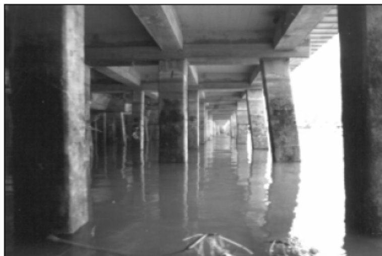
FIGURA 113. RECORRIDO E INSPECCION DE UNA ESTRUCTURA.
