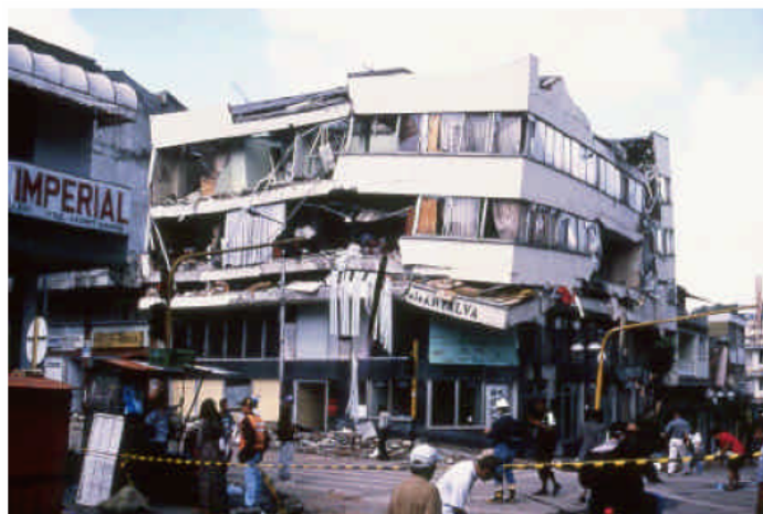
FIGURA 3. EDIFICIO DE CONCRETO ARMADO CONSTRUIDO SIN EL CUMPLIMIENTO DE LOS REQUISITOS DE LAS NORMAS.
