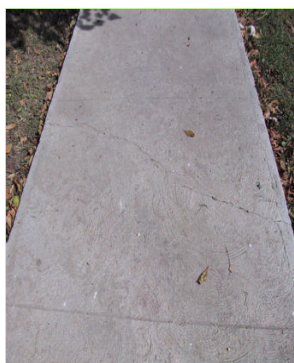
FIGURA 43. EJEMPLOS DE CONTRACCIÓN POR SECADO.
