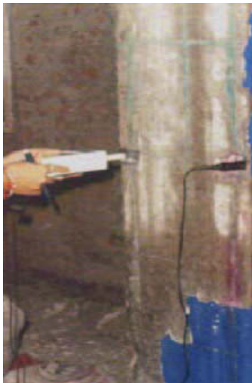
FIGURA 121. PRUEBA DE CORROSIÓN REALIZADA EN UNA COLUMNA. TANTO LA SUPERFICIE DE CONCRETO COMO LA ESPONJA DE LA MEDIA CELDA DEBÍAN ESTAR PREVIAMENTE HÚMEDAS.
