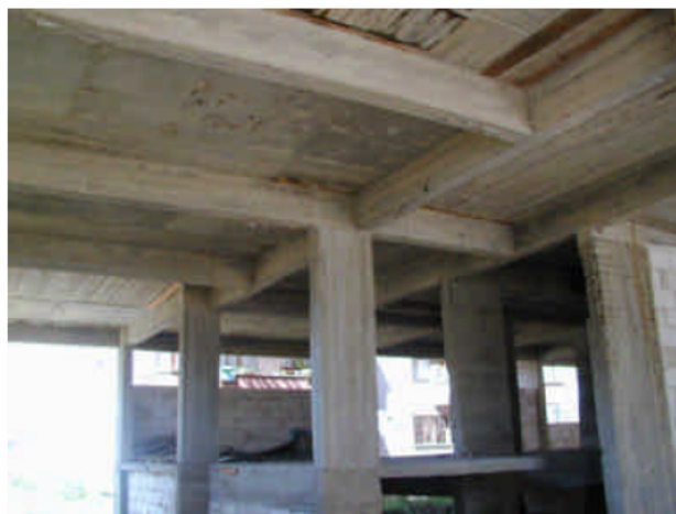
FIGURA 18. MALA CONFIGURACIÓN ESTRUCTURAL DE ENTRAMADOS QUE FORMAN PÓRTICOS.
