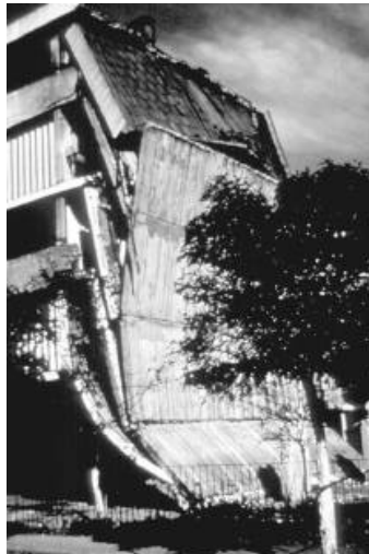
FIGURA 25. COLAPSO ESTRUCTURAL DEBIDO A LA DISCONTINUIDAD DE ELEMENTOS VERTICALES.
