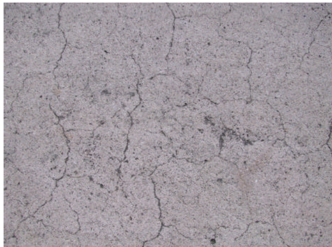
FIGURA 40. EJEMPLO DE CONTRACCIÓN PLÁSTICA.
