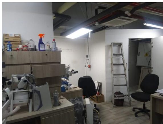
Imagen 20. Cuarto de mantenimiento (Mezzanine).
