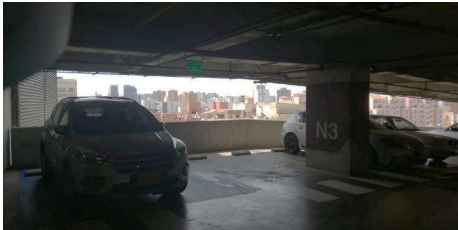
Imagen 42. Parqueadero con ventilación natural
