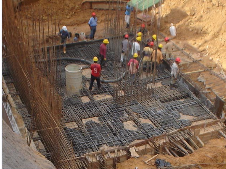
Figura 92. Fundida de la placa aligerada de cimentación
