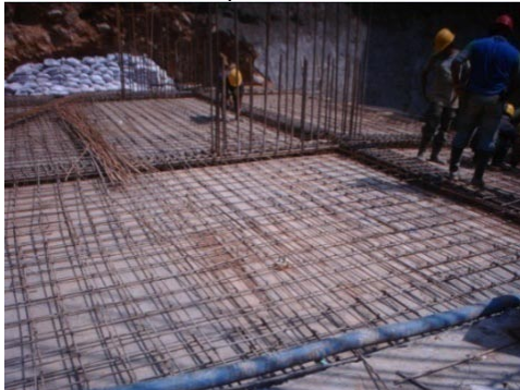
Figura 143. Armado de la placa maciza
