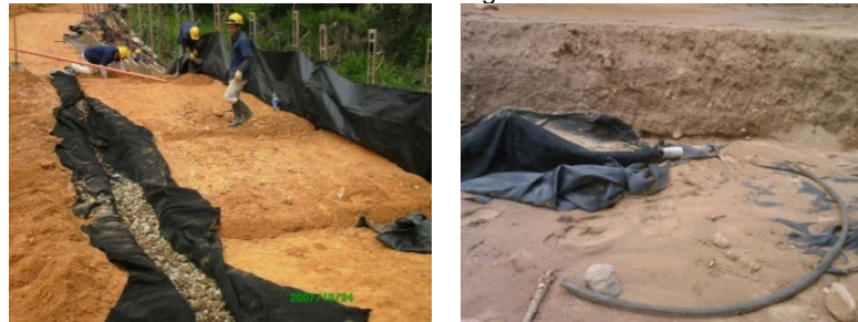
Figura 269. Construcción de filtro Francés e instalación de geodren circular
