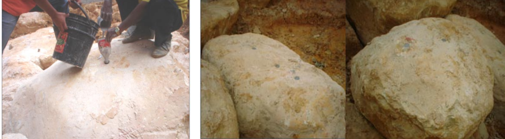
Figura 71. Llenado de las perforaciones con el producto
