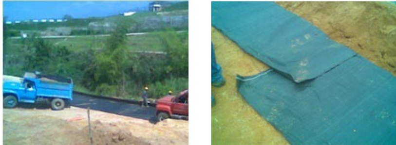
Figura 259. Extendida del geotextil y traslapos
