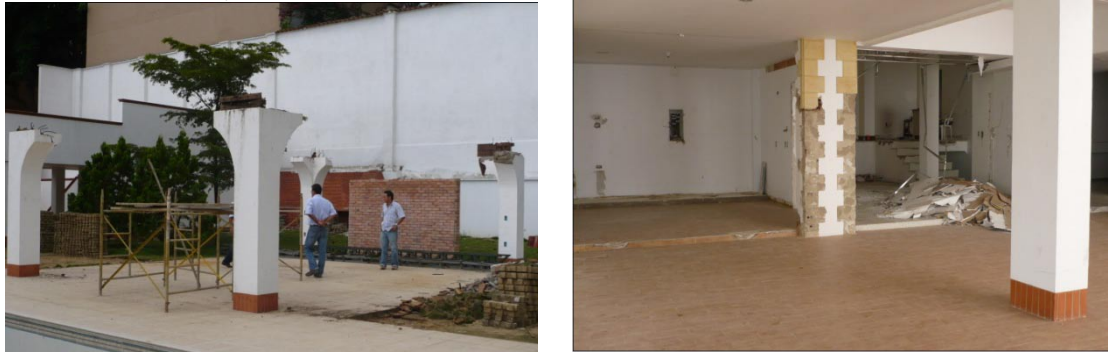
Figura 49. Desocupada y dismantelada de la vivienda
