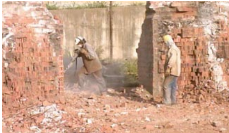
Figura 40. Demolición manual de estructura con martillo neumático
