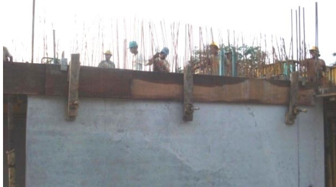
Figura 179. Formaleta en borde de placa
