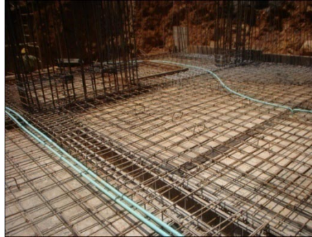
Figura 144. Ubicación de instalaciones eléctricas
