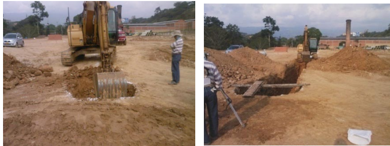
Figura 272. Zanjas de alcantarillado con retro-excavadora
