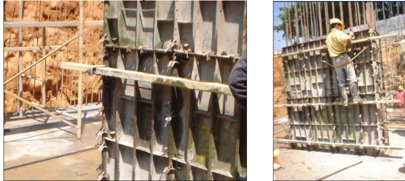
Figura 117. Instalación de los alineadores ajustados con los tensores
