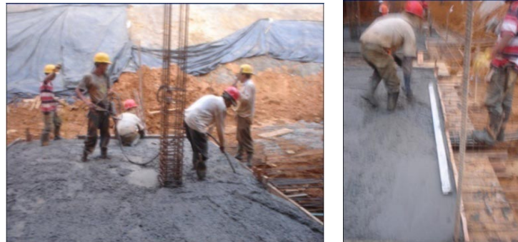
Figura 147. Vibrada del concreto y elaboración de alistados para nivelación
