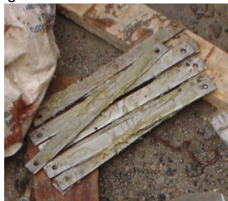
Figura 114. Engrasada de corbatas e introducción a las fundas
