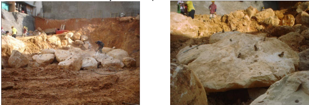
Figura 69. Perforación de la roca con la ayuda de compresor
