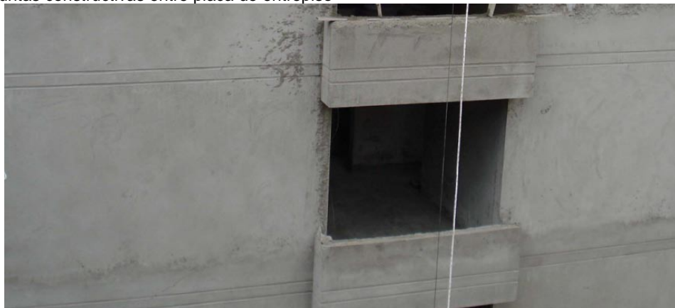
Figura 208. Juntas constructivas entre placa de entrepiso
