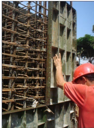
Figura 116. Continuación del armado de los tableros
