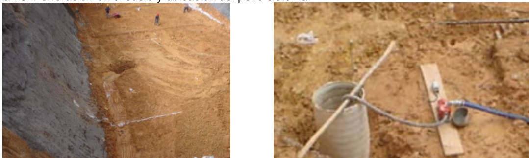
Figura 76. Perforación en el suelo y ubicación del pozo cisterna
