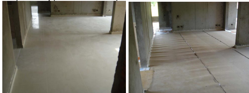
Figura 243. Vista enchapado final y protección de enchapado
