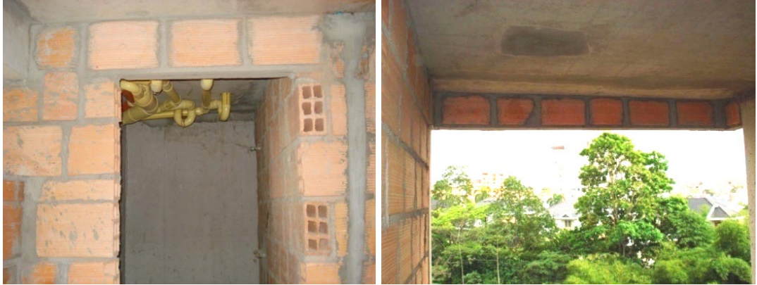
Figura 198. Dintel (izq.) y descolgado (der.)
