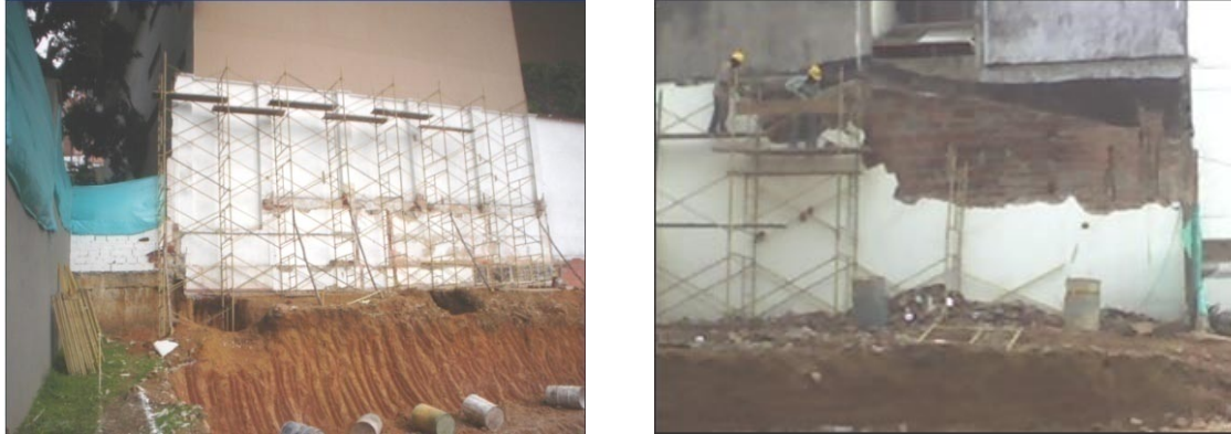
Figura 54. Instalación de andamios y demolición de doubles muros
