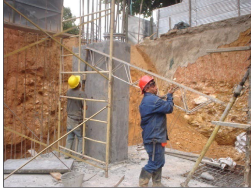
Figura 132. Ubicación de la cercha entre columnas
