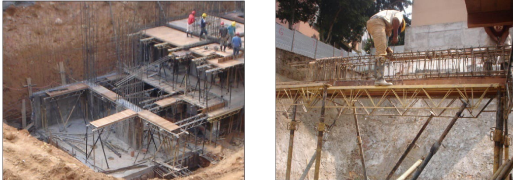
Figura 139. Ubicación de tableros para vigas descolgadas y armado de las mismas
