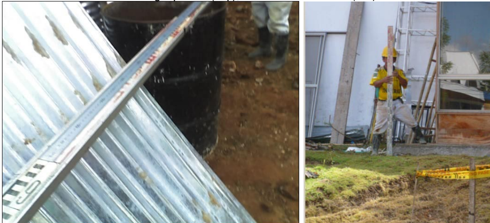
Figura 11. Verificación de mira con regla patrón (izq.), Verticalidad de mira (der)
