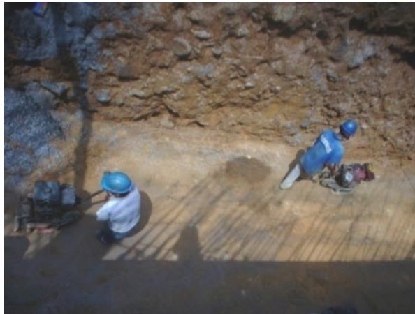
Figura 162. Relleno tras muro de contención
