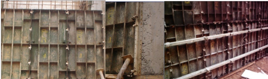
Figura 158. Encofrado del muro de contención
