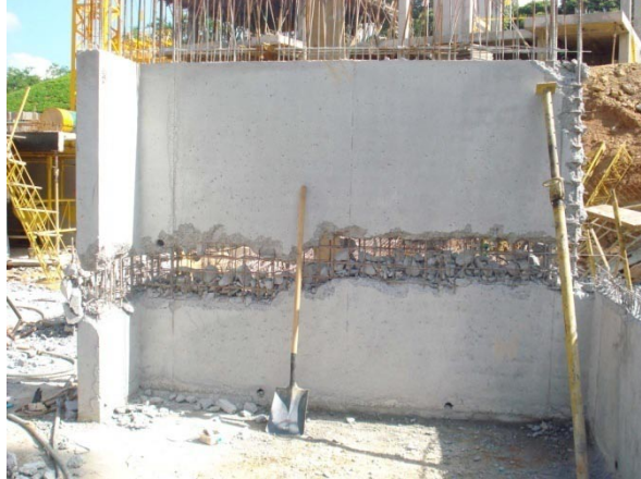
Figura 15. Demolición de muro estructural por mostrar baja resistencia a 3 días
