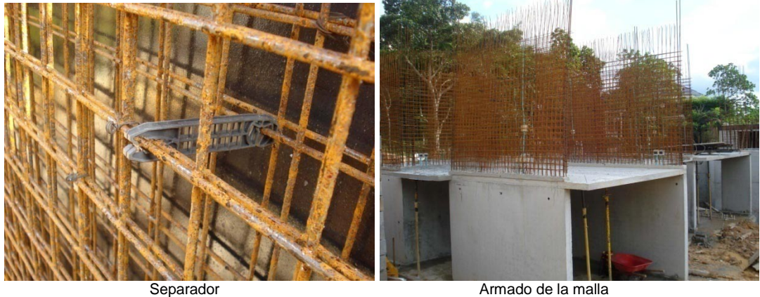
Figura 166. Armado de malla
