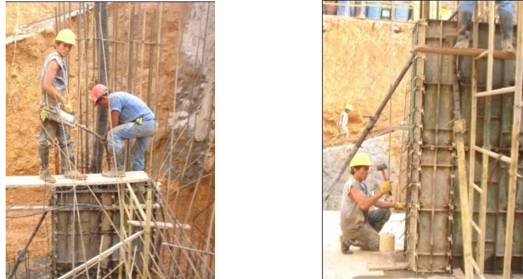
Figura 123. Eliminación del aire del concreto
