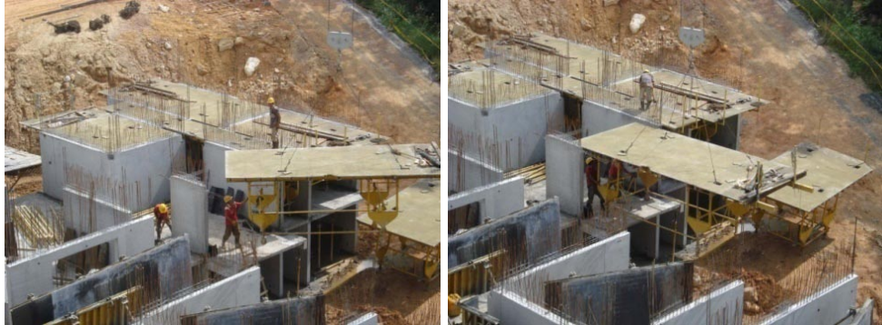
Figura 176. Formateado de la placa
