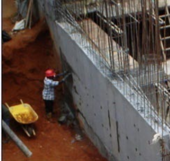
Figura 161. Impermeabilización del muro de contención
