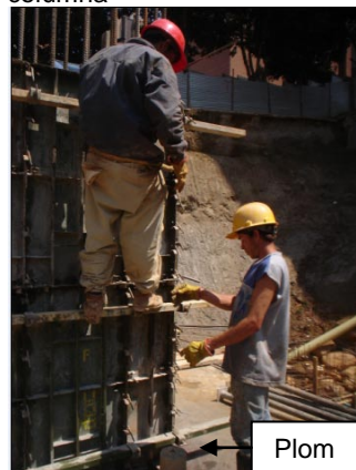
Figura 119. Instalación de plomos en la columna
