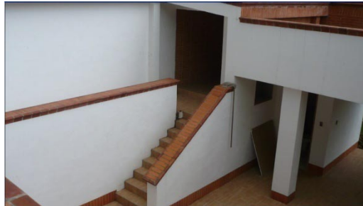
Figura 33. Determinación del estado de la estructura
