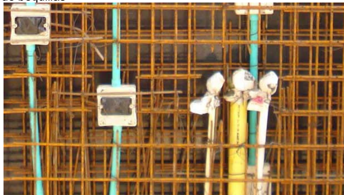
Figura 167. Cubrimiento de boquillas
