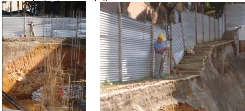
Figura 107. Marcación de ejes por parte del topógrafo
