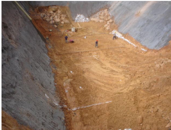
Figura 78. Replanteo a nivel de cimentación
