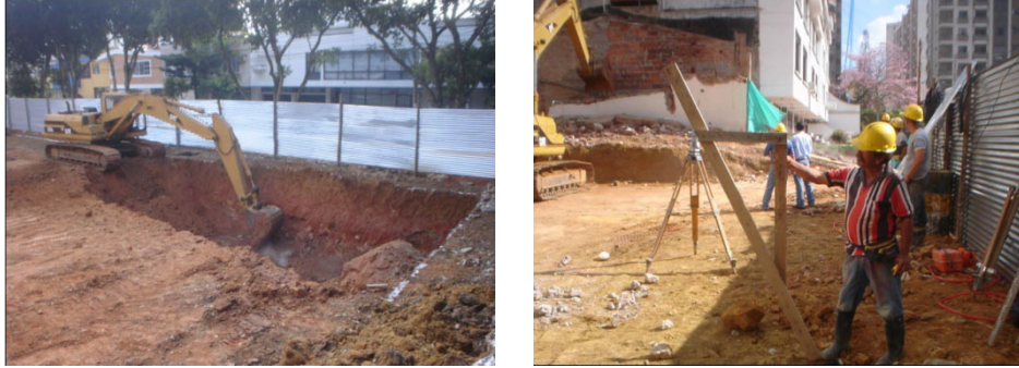
Figura 67. Continuación de excavación y regla para control de pendiente de taludes
