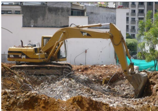
Figura 53. Proceso de demolición 2
