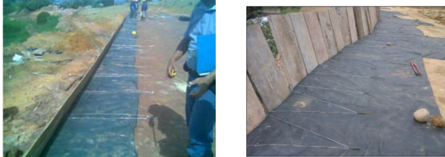
Figura 266. Anclajes de formaleta temporal
