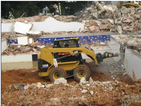
Figura 52. Proceso de demolición 1
