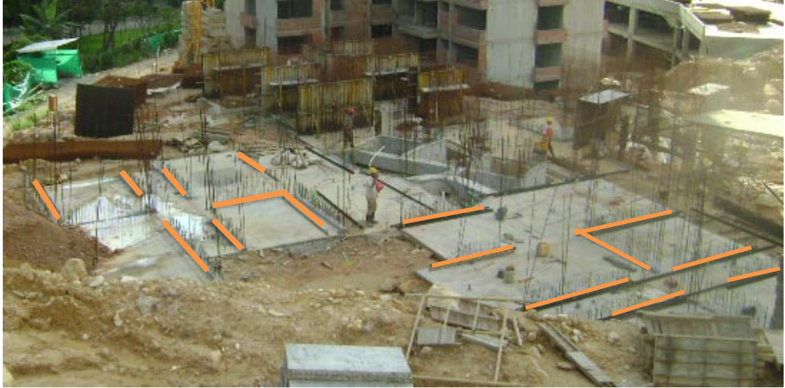
Figura 164. Replanteo de muros estructurales
