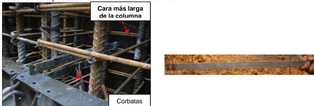
Figura 98. Corbata y ubicación de la misma dentro de la columna
