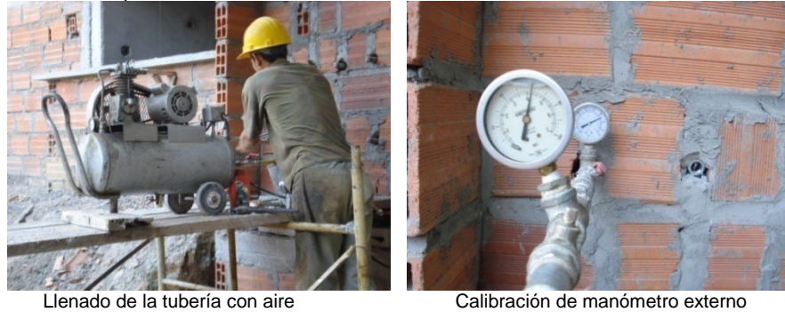
Llenado de la tubería con aire
