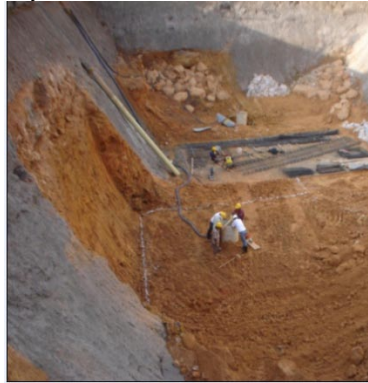
Figura 85. Demarcación con cal de los ejes de cimentación
