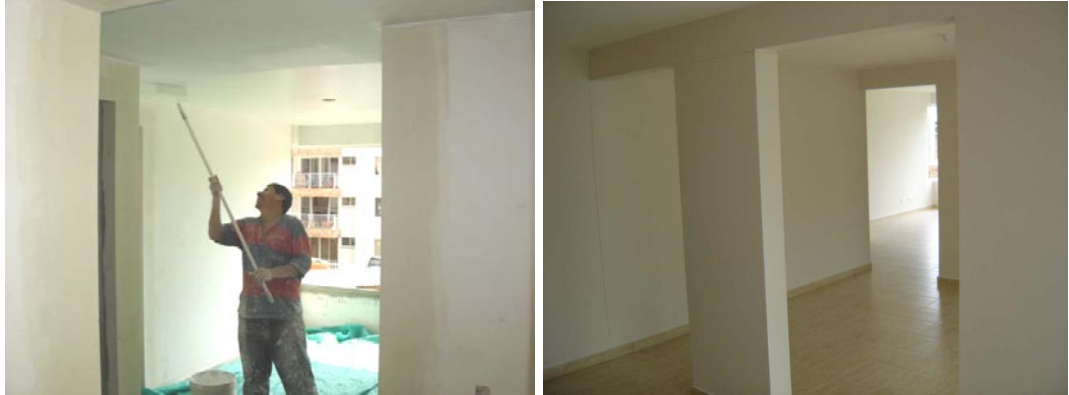
Figura 250. Tercera mano de pintura
