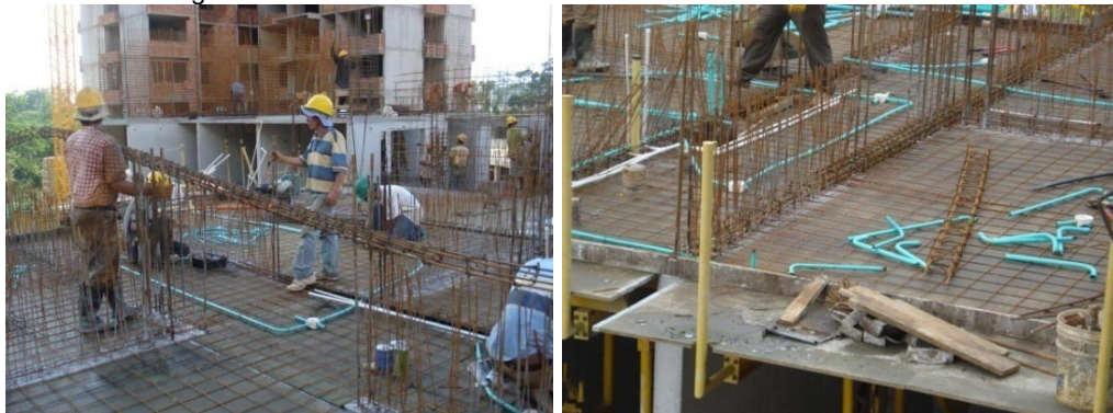
Figura 183. Instalación de vigas sobre muros
