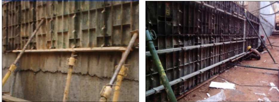
Figura 159. Apuntalamiento de tableros del muro de contención
