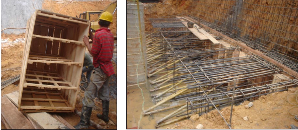
Figura 90. Armada y fundida de la viga de borde
