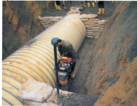
Figura 275. Conformación de atraque de la tubería
