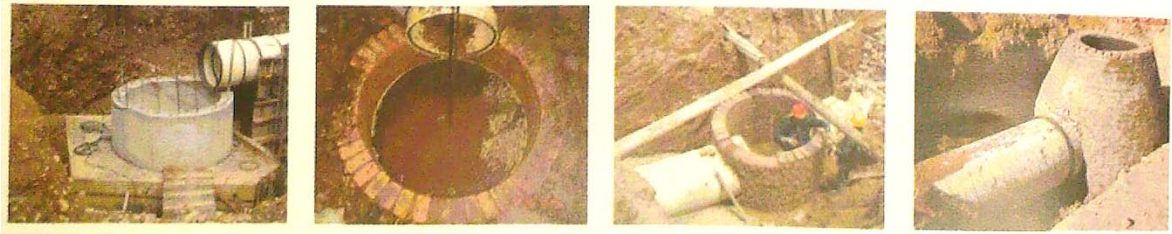
Figura 278. Construcción de pozo de inspección pluvial
