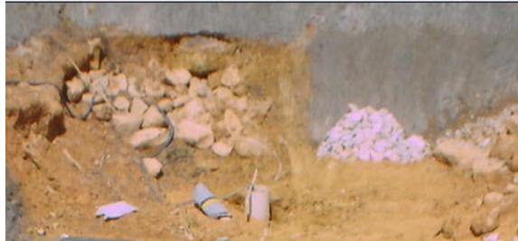
Figura 77 .Instalación de contrapeso en el pie del talud
