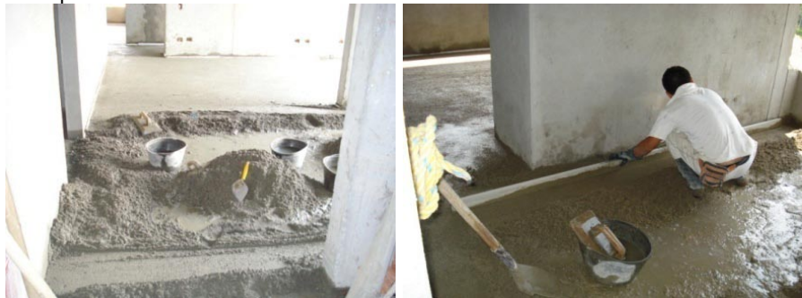
Figura 233. Mortero de piso
