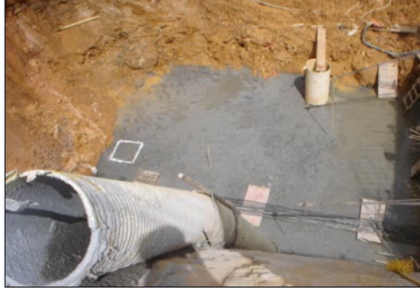
Figura 88. Aplicación de concreto de limpieza
