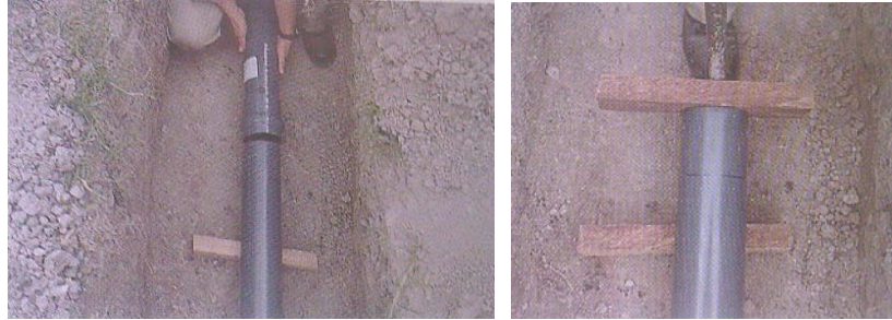
Figura 281. Instalación de tubería de acueducto
