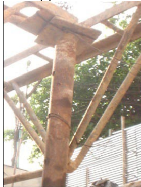
Figura 138. Continuación de armado de cerchas y parales
