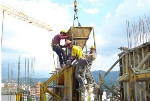
Figura 174. Vaciado y vibrado de muros estructurales
