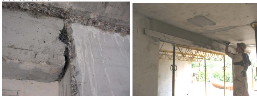
Figura 191. Resane de estructura
