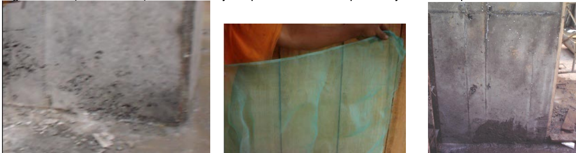
Figura 126. Apariencia de pantalla antes y después de resane superficial y tela verde para cernir
