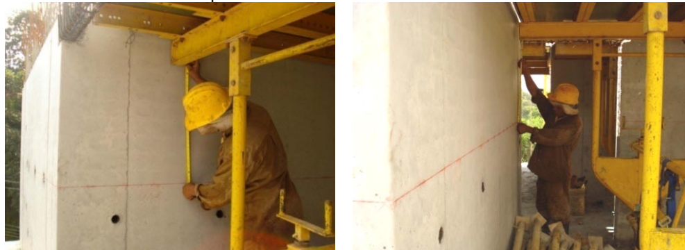
Figura 177. Verificación de la altura de la placa
