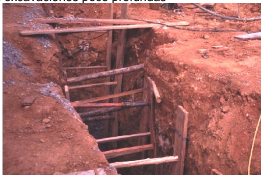
Figura 62. Apuntalamientos en excavaciones poco profundas
