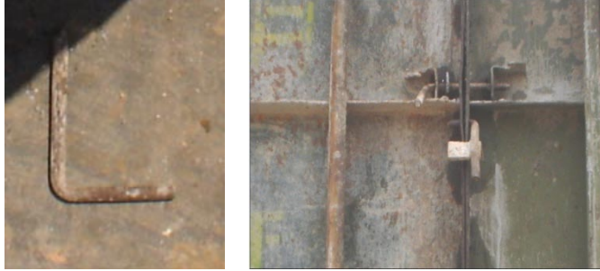
Figura 97. Pines y ubicación de los mismos para sujetar las corbatas
