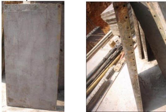
Figura 104. Tableros metálicos manoportables
