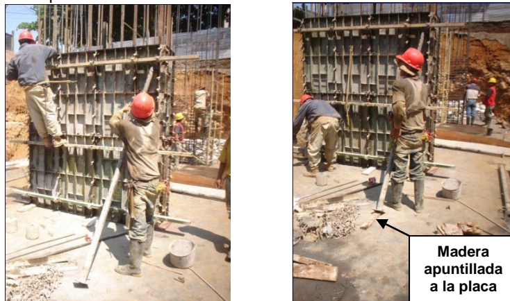
Figura 120. Instalación de parales
