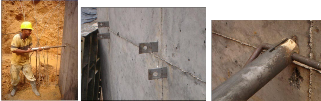
Figura 125. Retiro de corbatas
