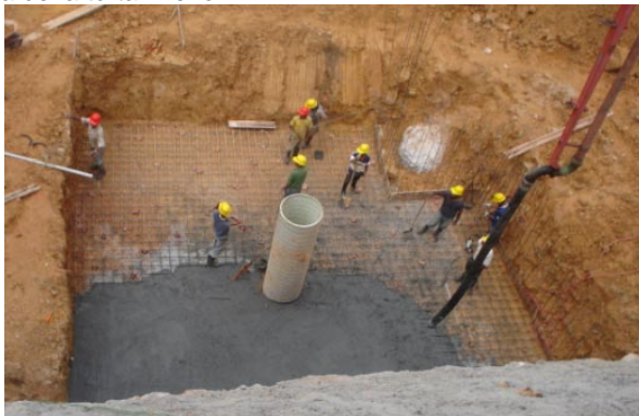
Figura 89. Armada y fundida de la torta inferior
