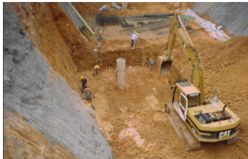
Figura 86. Excavación para la placa de cimentación
