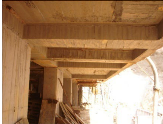
Figura 151. Aspecto de la placa maciza después del desencofrado
