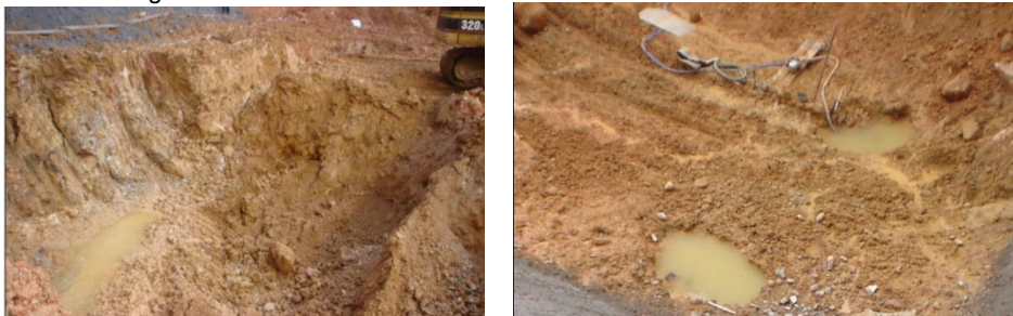
Figura 75. Succión de agua a través de motobomba
