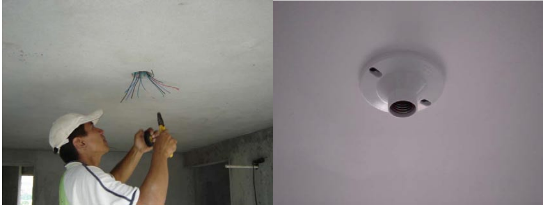
Figura 228. Instalación de aparatos
