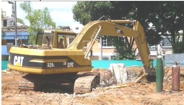
Figura 45. Retroexcavadora utilizada para demolición
