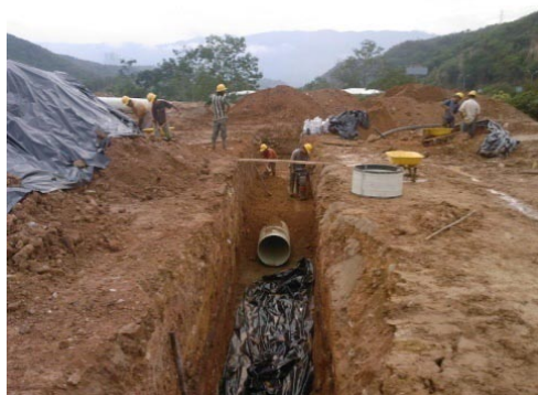
Figura 276. Relleno con material seleccionado
