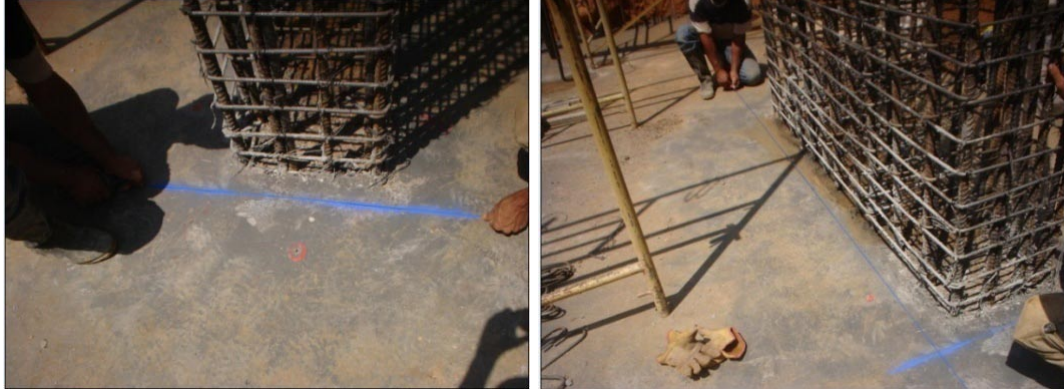
Figura 110. Cimbrada de la pantalla
