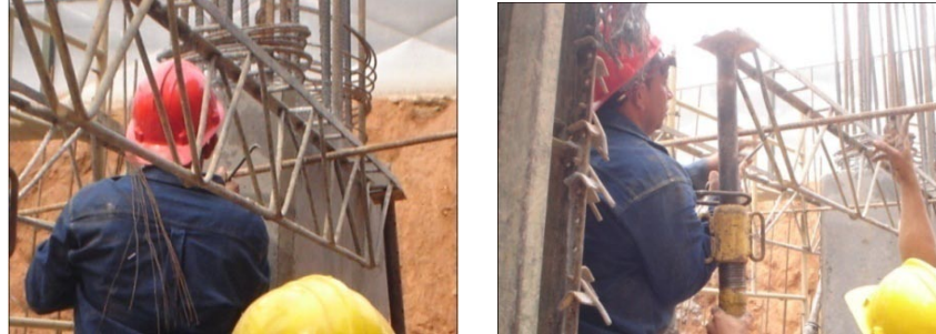
Figura 137. Instalación de contravientos
