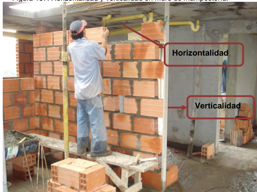
Figura 197. Horizontalidad y verticalidad en muro de mampostería.
