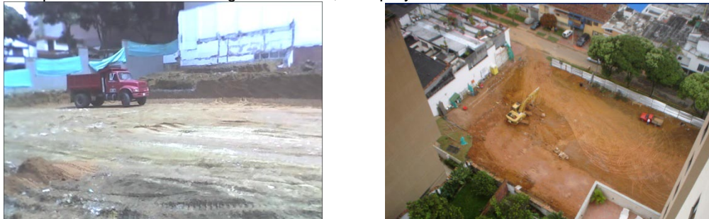
Figura 66. Replanteo cuando se ha llegado a nivel 0,0 del proyecto
