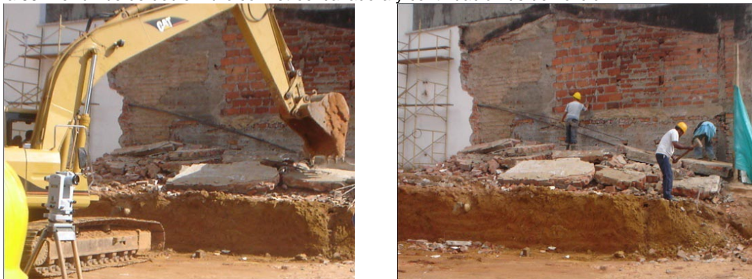
Figura 55. Derrumbe de doble muro con retroexcavadora y continuación de demolición
