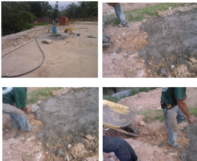
Figura 294. Construcción de canaleta chafarreada
