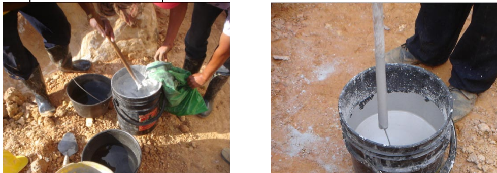
Figura 70. Preparación del cemento expansivo
