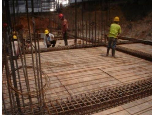
Figura 142. Instalación de tableros para placa maciza
