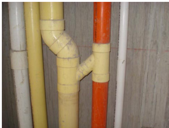
Conexión intermedia de ventilación a bajante A.N.
