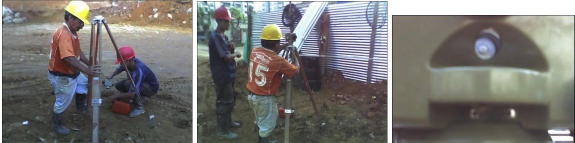
Figura 10. Instalación y nivelación del Nivel de Precisión
