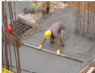
Figura 148. Nivelada del concreto en placa maciza
