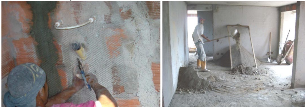
Figura 210. Instalación de malla y cernida de arena
