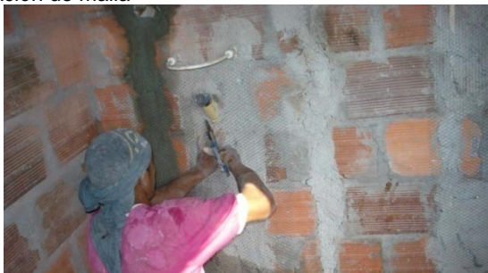
Figura 215. Embone e instalación de malla
