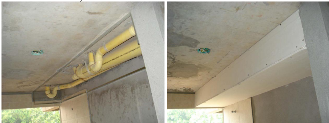
Figura 224. Cielo raso en Dry Wall
