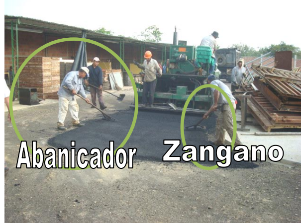
Figura 289. Distribución de capa asfáltica con abanicadores
