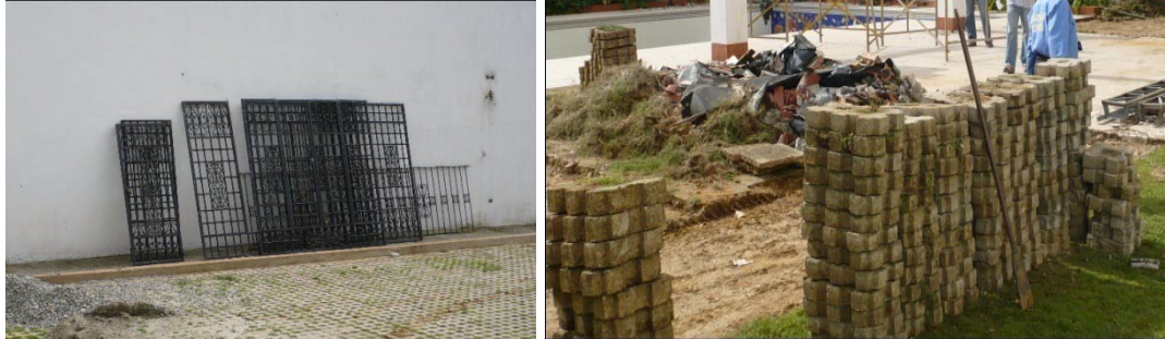
Figura 34. Elementos recuperables de la edificación anterior
