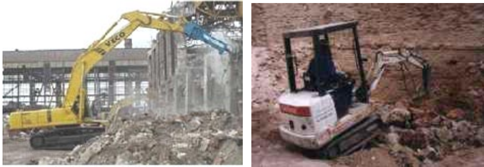
Figura 41. Maquinaria utilizada para demolición con martillo hidráulico
