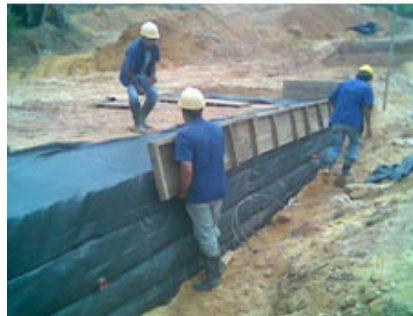
Figura 265. Instalación, apoyo y anclaje de la formaleta temporal
