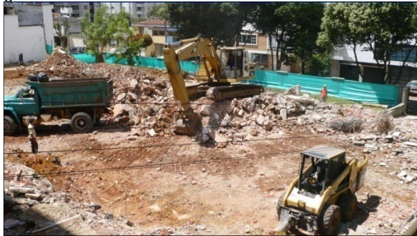
Figura 57. Retiro de escombros de la obra
