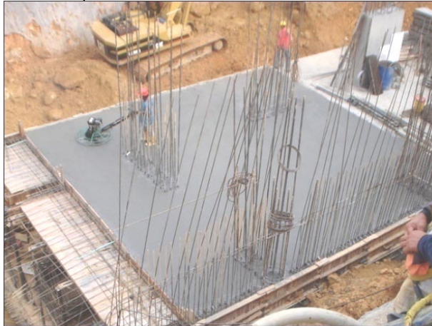
Figura 149. Nivelación y pulida de la placa
