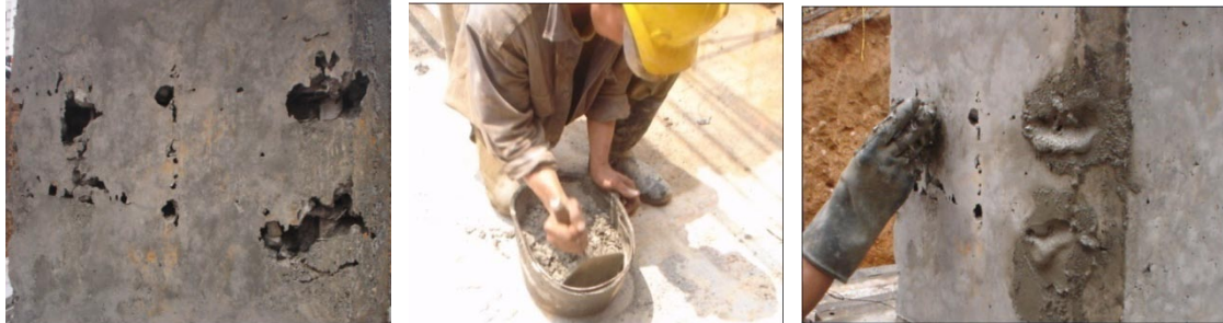
Figura 127. Procedimiento para realizar resanes mayores
