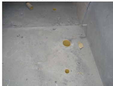
Figura 239. Corte de prolongaciones de instalaciones sanitarias
