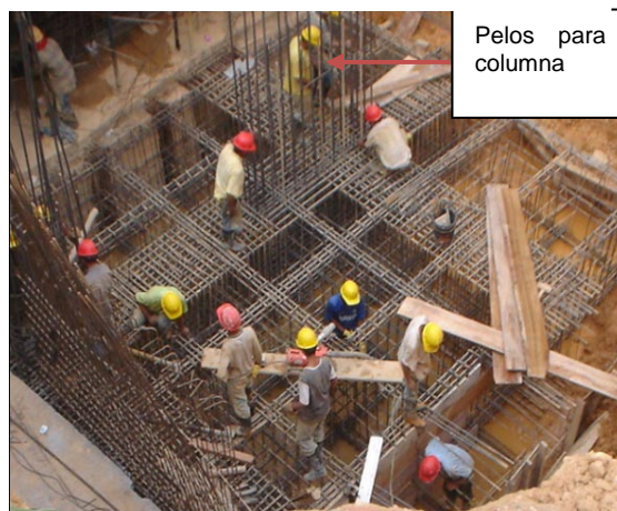
Figura 91. Armada de la placa aligerada de cimentación
