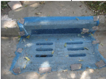
Figura 64. Instalación de malla de poro fino en sumidero y cubrimiento de material en las volquetas
