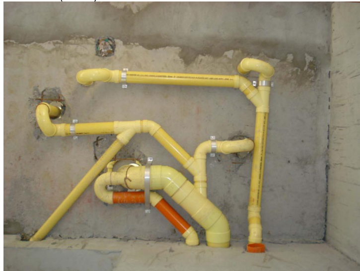
Figura 22. Instalación Sanitaria (araña)
