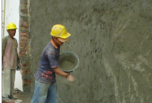
Figura 56. Frisado e impermeabilizado de muro vecino
