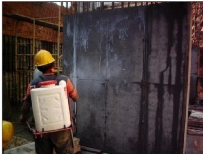
Figura 128. Aplicación de antisol
