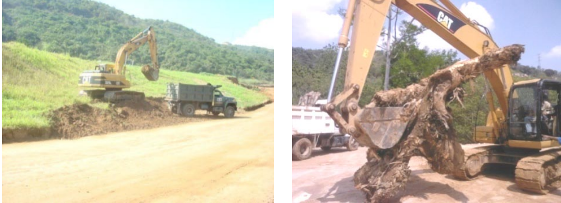
Figura 252. Retiro de capa vegetal y sacada de raíces
