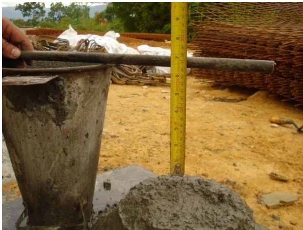
Figura 13. Asentamiento de concreto
