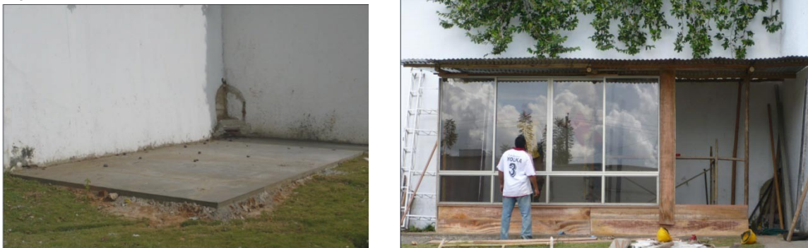
Figura 50. Construcción de campamento
