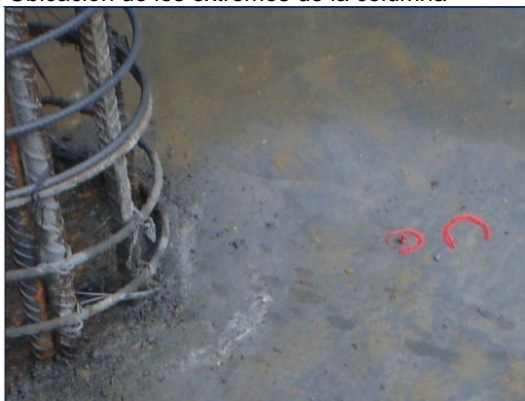
Figura 109. Ubicación de los extremos de la columna
