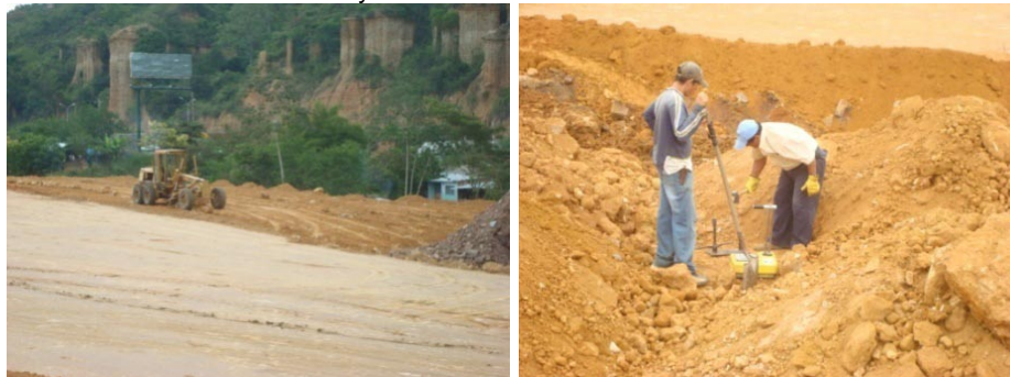
Figura 255. Extendida de material interno y toma de densidades
