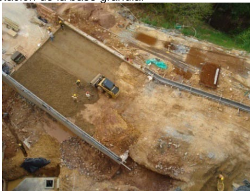
Figura 285. Extendida y compactación de la base granular
