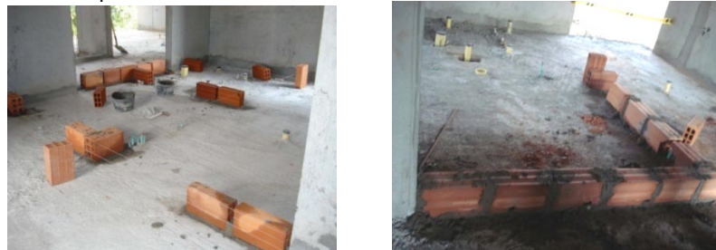
Figura 193. Replanteo de mampostería.
