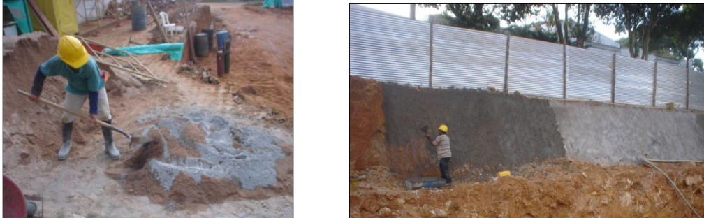
Figura 65. Preparación y aplicación de mortero para chafarreo de taludes
