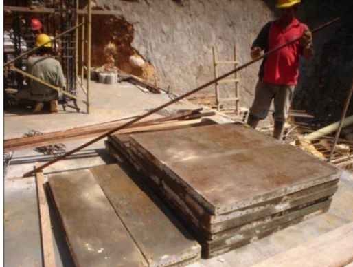
Figura 108. Aplicación de ACPM y grasa a los tableros y esquineros
