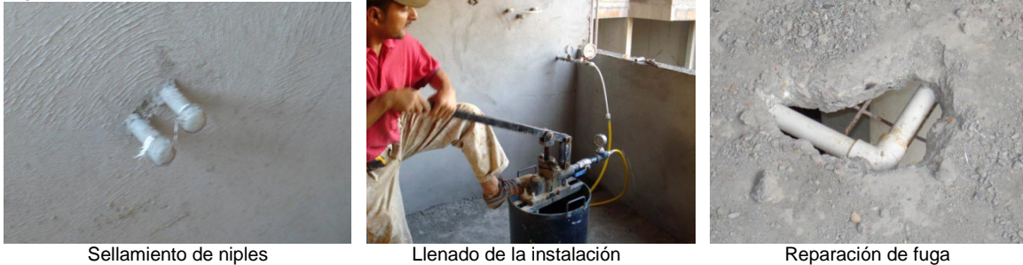
Figura 26. Realización de prueba hidráulica
