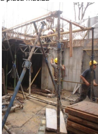
Figura 141. Instalación de formaleta para placa maciza
