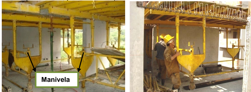
Figura 178. Manivelas para subir o bajar la altura de la placa
