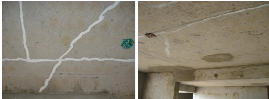
Figura 245. Aplicación de sellante en ranuras del techo
