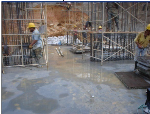
Figura 150. Curado de la placa
