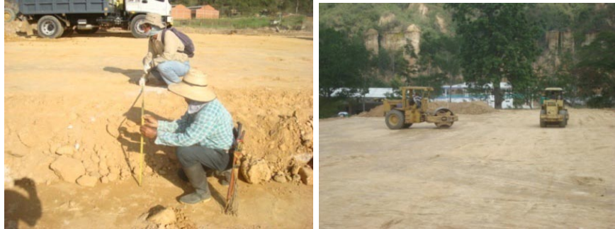
Figura 254. Capa de relleno y compactación con Vibro-Compactador
