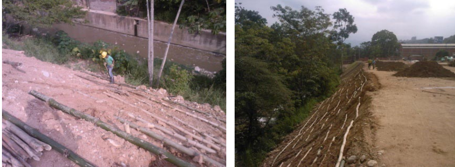
Figura 293. Instalación de Bambú
