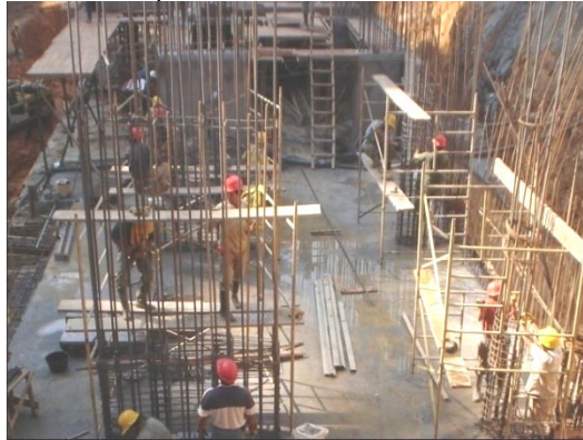
Figura 106. Continuación del armado de la pantalla
