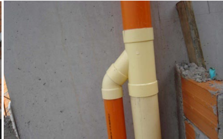
Prolongación de ventilación al techo
