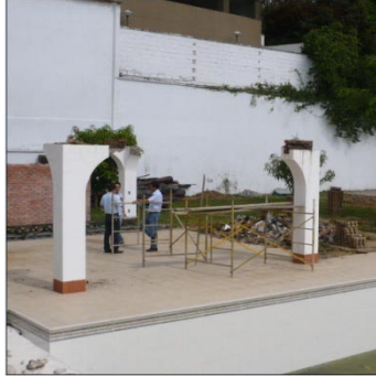
Figura 36. Ubicación de andamios para demolición
