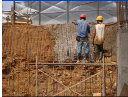
Figura 153. Continuación del armado de refuerzo
