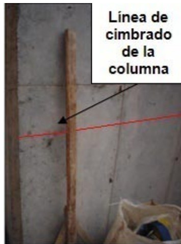
Figura 130. Cimbrada de columna para referencia de altura
