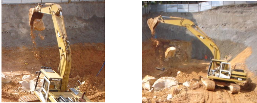
Figura 74. Procedimiento para fragmentar la roca fracturada
