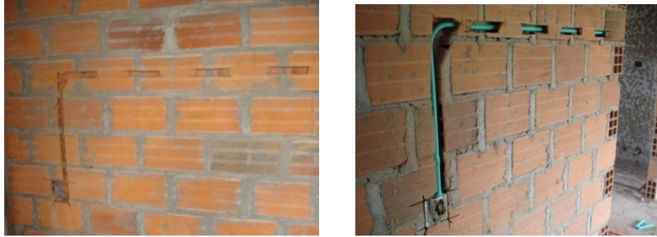
Figura 225. Regata para instalación eléctrica
