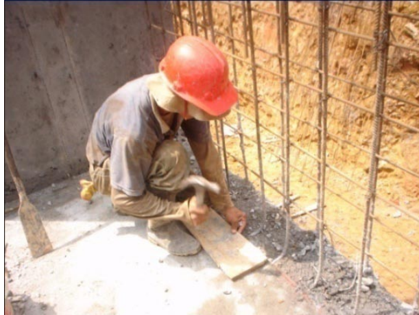
Figura 157. Instalación de tableros del muro
