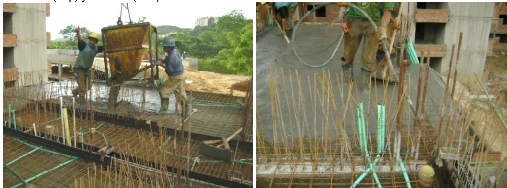
Figura 185. Vaciado (izq.) y vibrado (der.)
