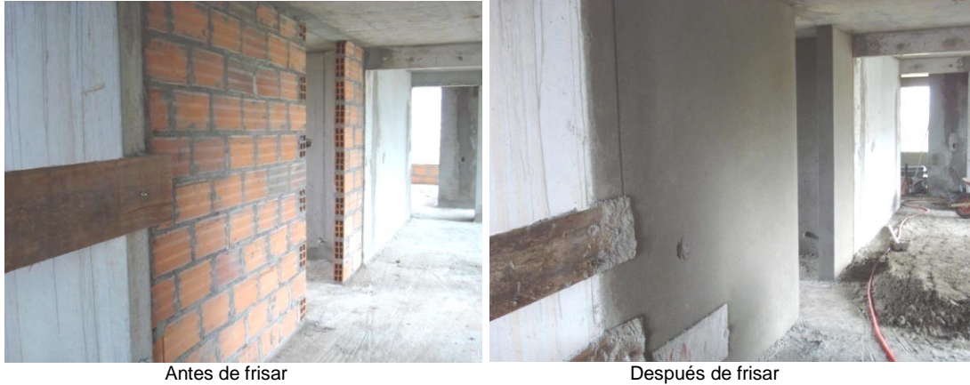
Figura 209. Friso de muro
