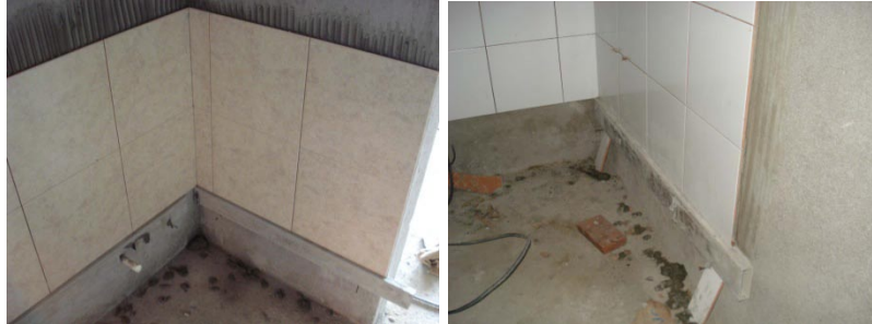
Figura 240. Instalación de codal
