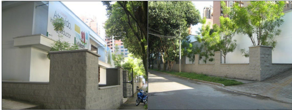
Figura 32. Visita de reconocimiento
