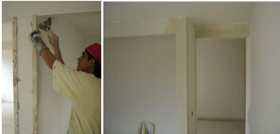
Figura 249. Realización de filos
