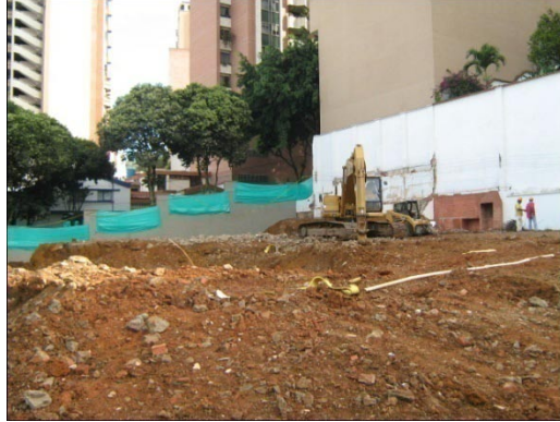
Figura 63. Excavación para alcanzar el nivel 0,0 del proyecto
