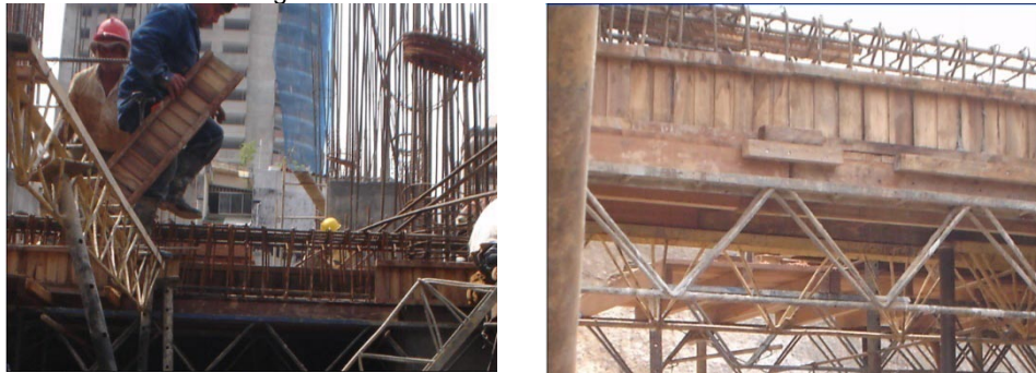
Figura 140. Formaleteado de la viga
