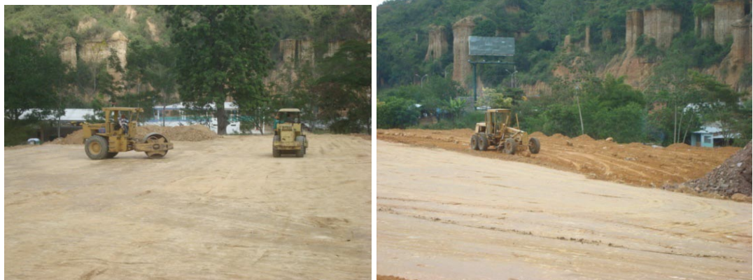
Figura 18. Extendida (izq.) y compactación (der.) de material
