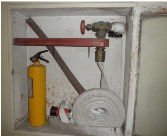
Estado físico de los gabinetes sin soportes y tuberías en colores diferentes
