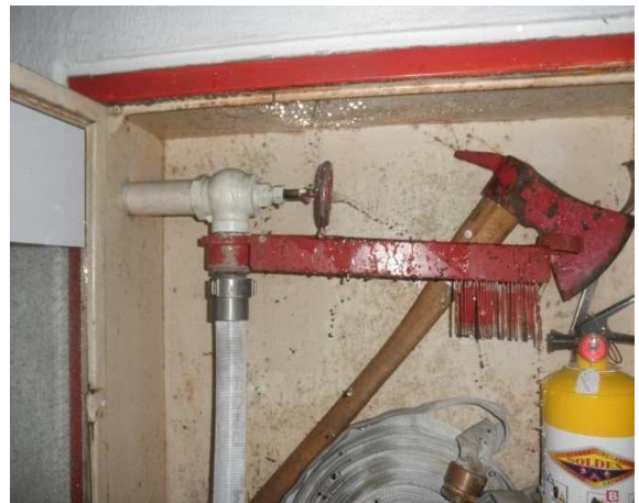
Estado físico de los gabinetes sin soportes y tuberías en colores diferentes
