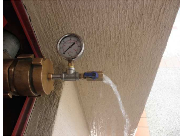
Potencia insuficiente en la bomba contra incendio
