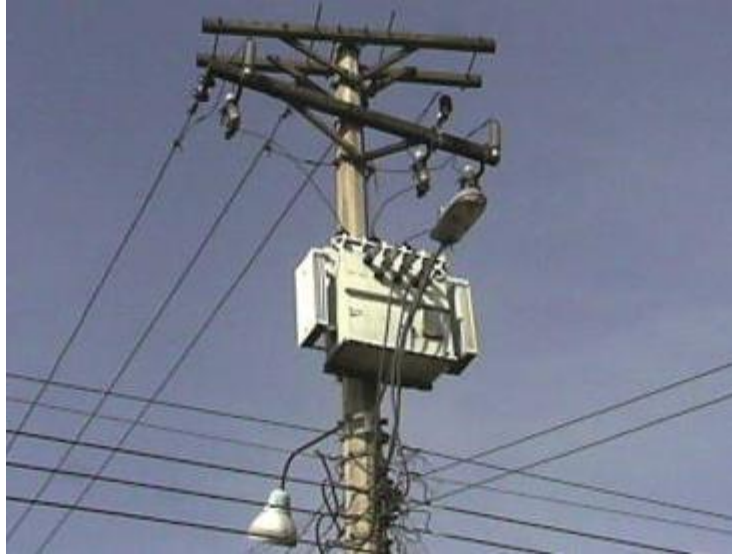
Figura 2. Subestación aérea.
