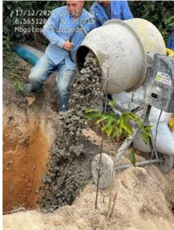
Vaciado de concreto
