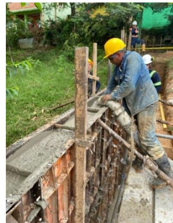
Vaciado de concreto en formaleta
