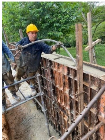
Vibrado de concreto
