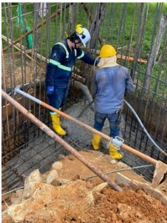
Vaciado de concreto en zarpa
