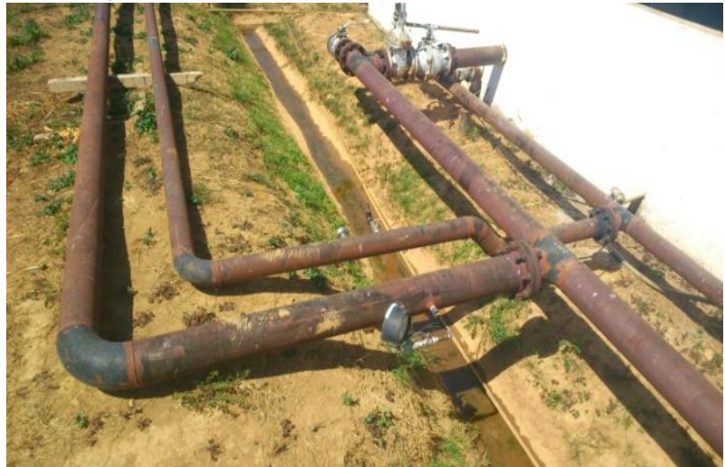
Figura 11. Instalación punto de rompedor inverso entrada de los GB 3y 4.
