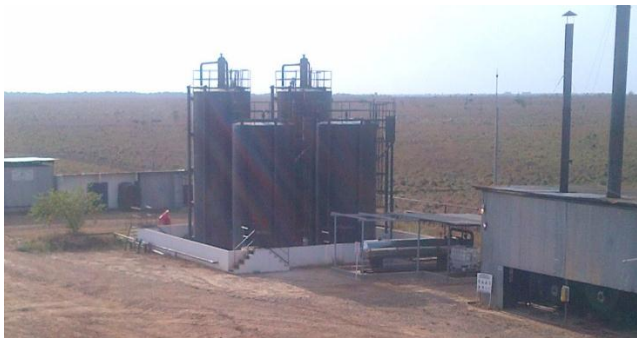
Figura 3. (a) GunBarrel 3 y 4 y Skimming tank 3 y 4 de la estación Cabiona 8 (b) Agua de proceso antes ingresar al sistema de tratamiento.
