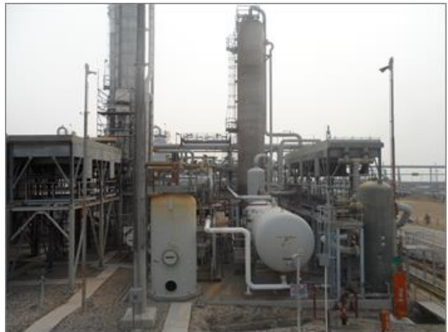
Fotografía. 3. Vasijas de separación Amina I
