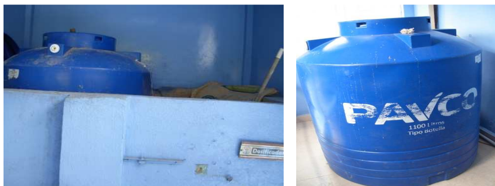
Figura 12. Tanques de 500 y 1100 litros donde se prepara la solución de coagulante.
