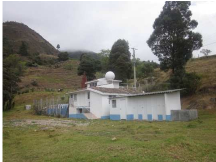
Figura 4. Planta de tratamiento de agua potable Cerrito, Santander.
