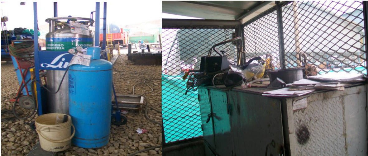
Ilustración N° 38. Área de soldadura, estado inicial segunda ese.
