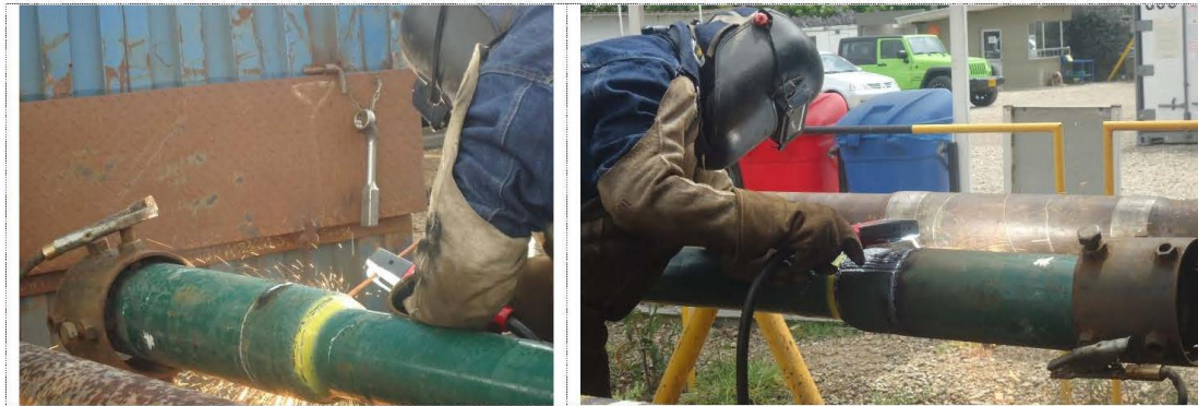
ILUSTRACIÓN 3. Remoción con un electrodo de carbono de 1/4" Arcair.
