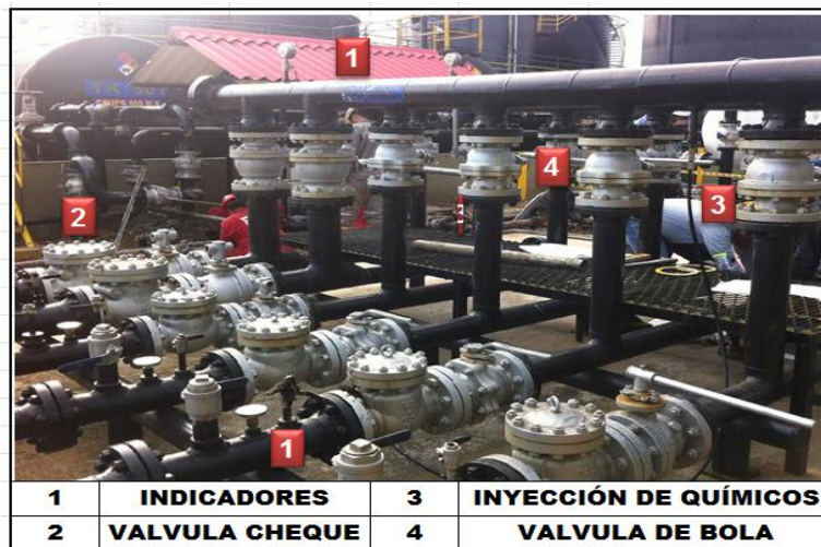
Figura 47. Instrumentación del múltiple de recolección.
