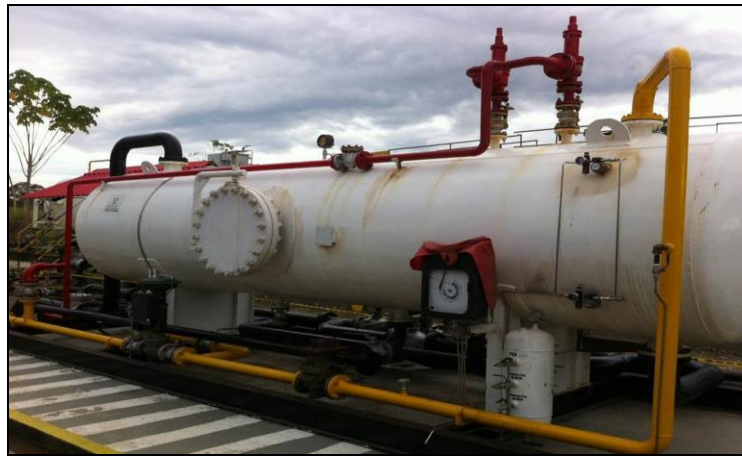
Figura 53. Separador de Producción.
