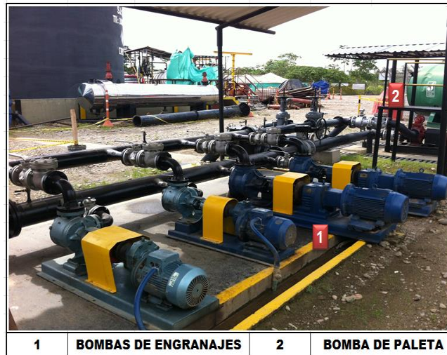
Figura 60. Sistema cargue de crudo.
