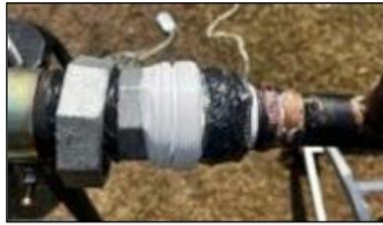
Figura 8. Cinta teflón aplicada sobre la unión.
