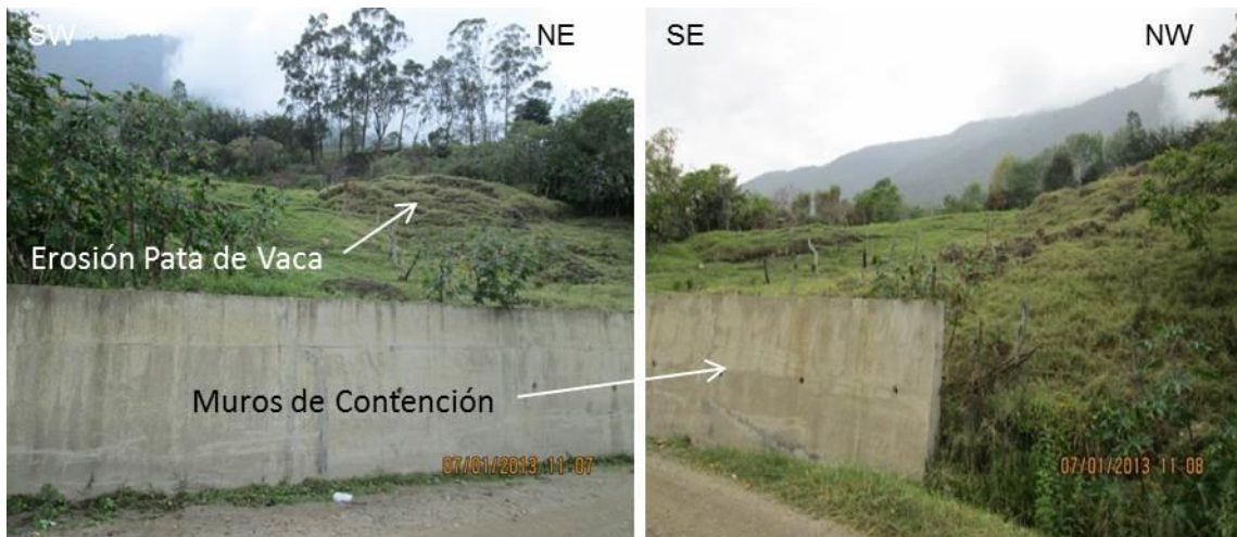
Figura 67. Deslizamiento rotacional en el Casco Urbano del municipio de Surata, departamento de Santander. Se observan obras de mitigación (muros de contención) y erosión en terracetas (pata de vaca).
