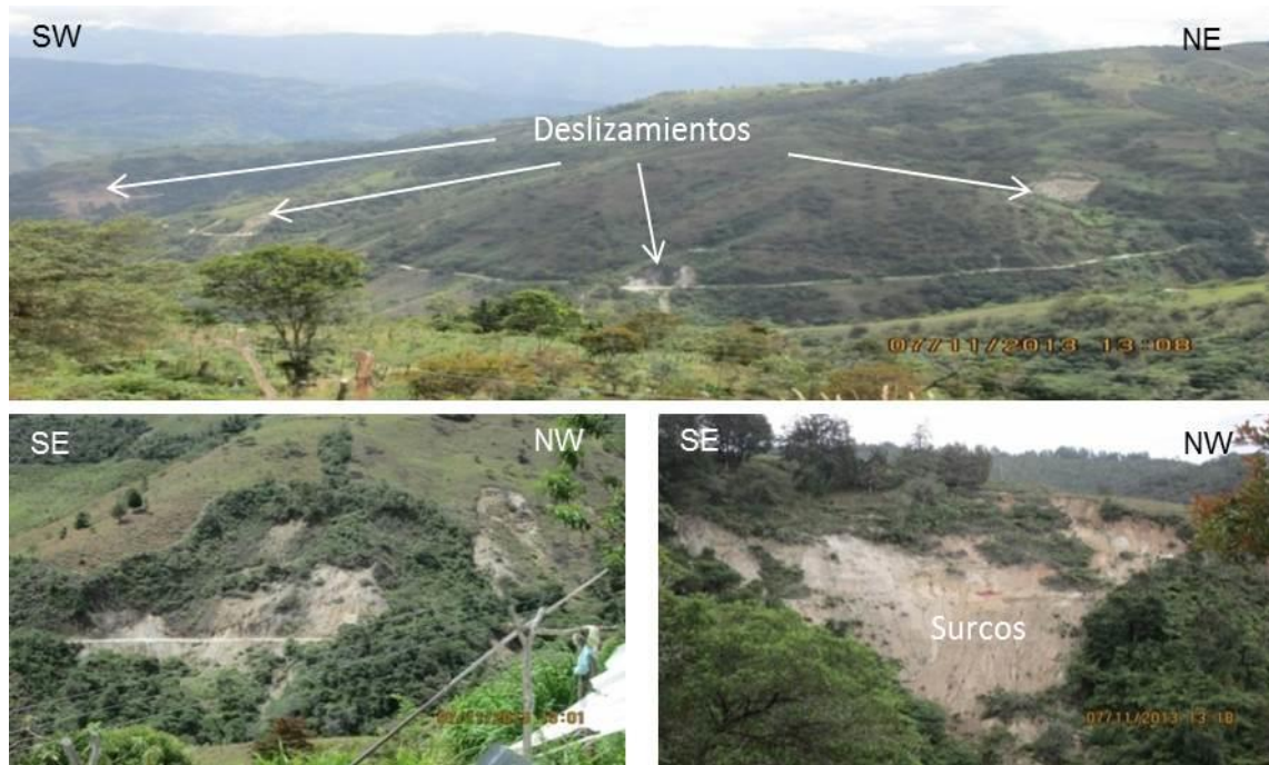
Figura 88. Deslizamientos traslacionales en la carretera que conduce del municipio de Pamplona con el Municipio de Cucutilla. Hacia la parte superior se observa una panorámica que muestra la presencia de enjambre de movimientos en la zona.
