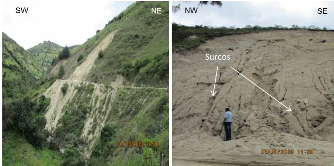
Figura 82. Deslizamiento traslacional planar, se observa erosión en surcos afectando al material expuesto, municipio de Cacota, departamento de Norte de Santander.
