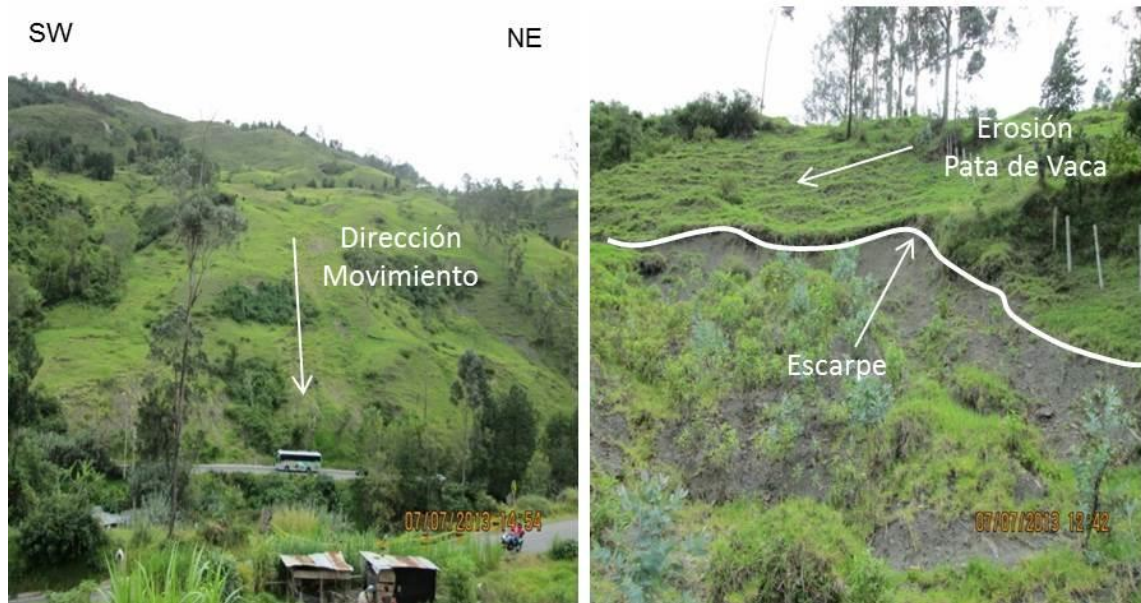
Figura 80. Deslizamiento rotacional sobre la carretera que conduce del municipio de Pamplona al municipio de Cúcuta, departamento de Norte de Santander.
