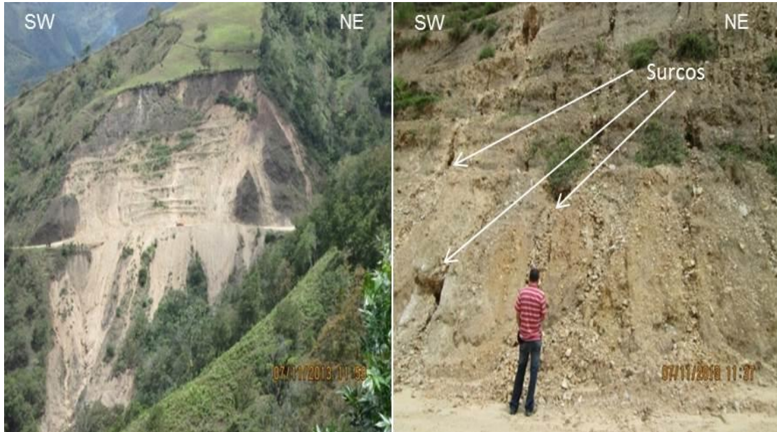
Figura 87. Deslizamiento traslacional con caída de roca, sus dimensiones no supera los 200 m de ancho por 200 m de longitud total, su afectación sobre la carretera es alta y se observa como agentes externos han generado erosión en surcos en el material que lo compone, municipio de Cucutilla, departamento de Norte de Santander.
