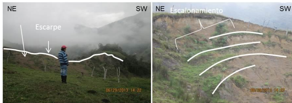
Figura 63. Deslizamiento rotacional, vereda La Cristalina del municipio de Charta, departamento de Santander. Se vieron afectados potreros y pastos; se observa escalonamiento.
