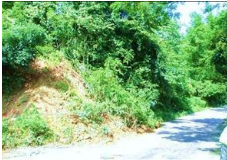
Figura 4. PR13+800. Deslizamiento rotacional en suelo, costado izquierdo.
