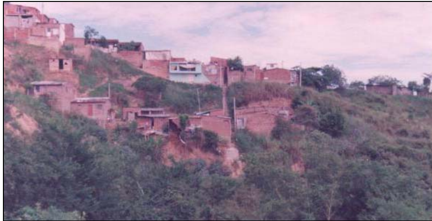
Figura 2. Zona de inestabilidad geológica. Construcción de viviendas en zonas altamente sensibles a la erosión y a los procesos de remoción en masa (CER, UIS, 1999).
