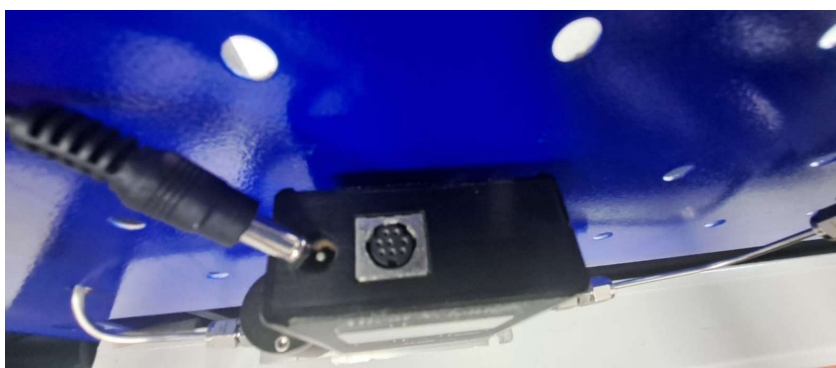
Figura 33. Conexión del CFM a la energía eléctrica
