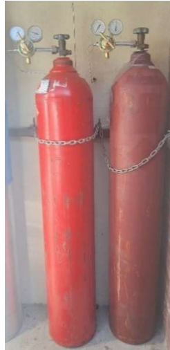
Figura 16. Instalación de cilindros con gases primarios
