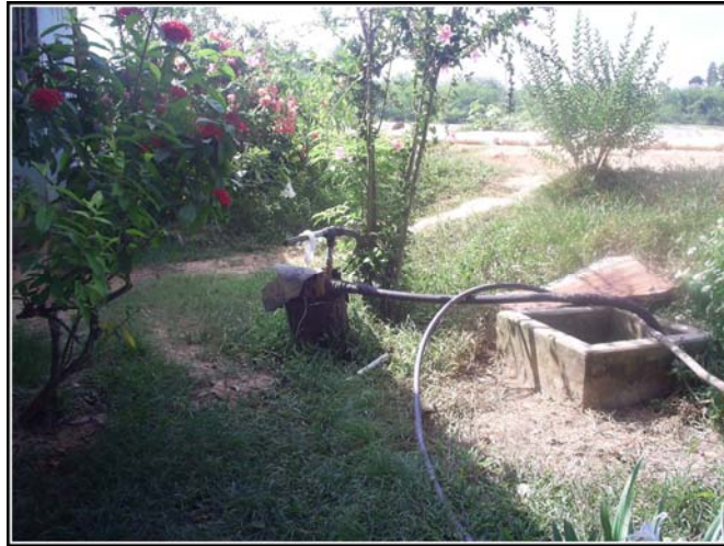
Pozo cisterna de 5 m y bomba de extracción de 0.5 HP
