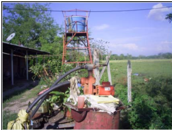
Izq.) Bomba de extracción de 2 HP. Der.) Tanque de almacenamiento de 5000 lts.
