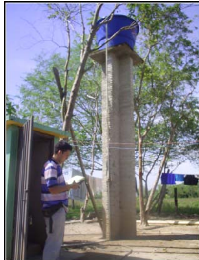
Izq.) Bomba de extracción 0.5 HP. Der.) Tanque de almacenamiento de 1000 lts.
