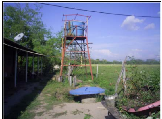
Izq.) Bomba de extracción de 2 HP. Der.) Tanque de almacenamiento de 5000 lts.
