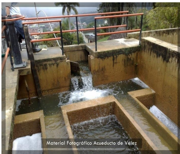
Foto 5,6: Tanques de filtración.
