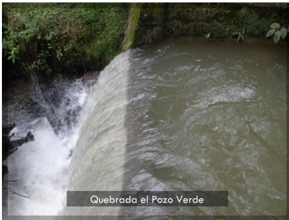
Foto 7: Tanque de captación.
