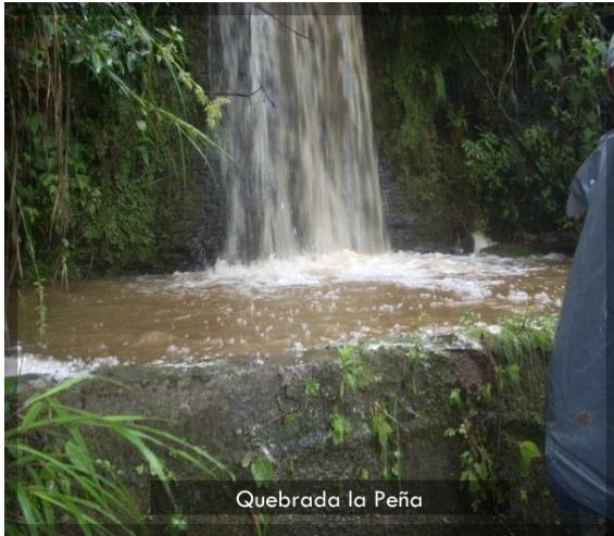
Foto 5: Tanque de captación
