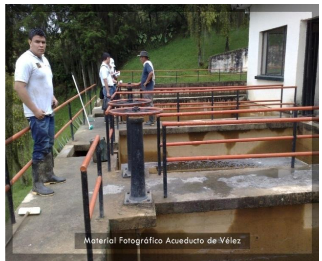
Foto 5,6: Tanques de filtración.
