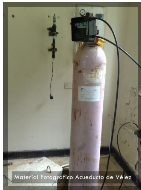
Foto 10: Bala de cloro usada en la Desinfección.
