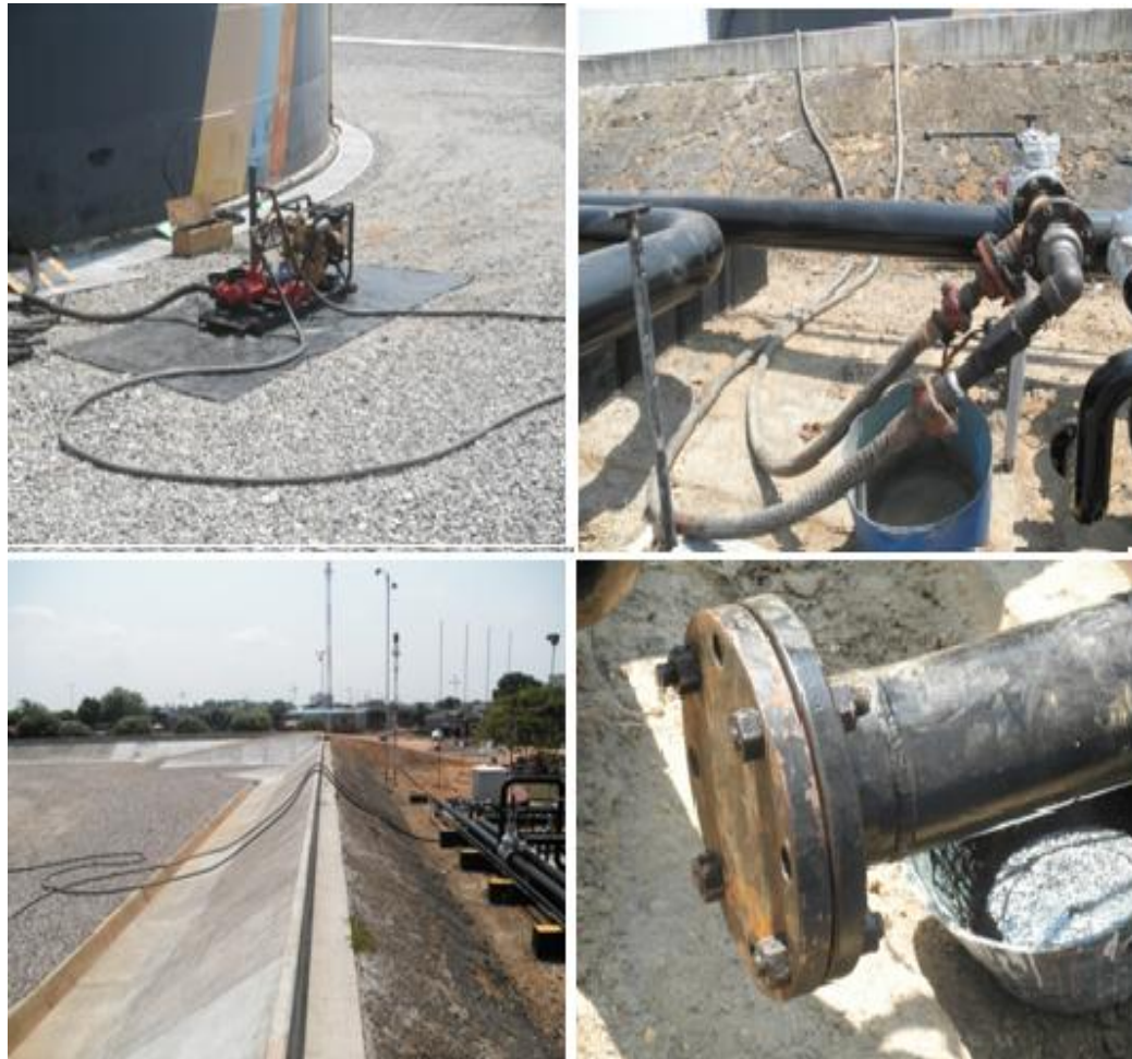
Figura 4. Implementación de bombeo de remanente tanque 90000-1.
