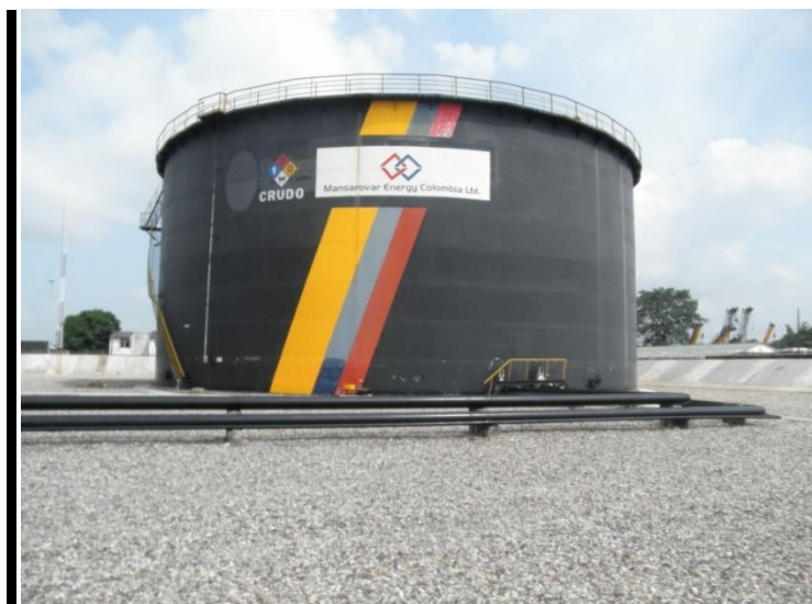
Figura 11. Tanque de almacenamiento de hidrocarburos con techo flotante.
