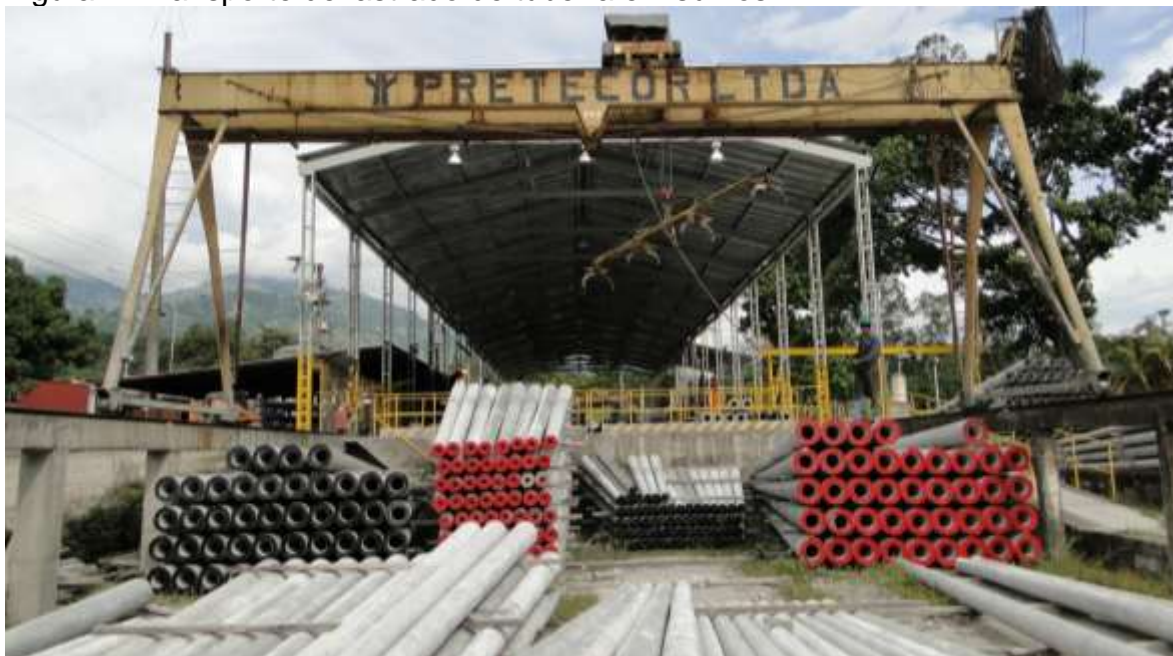
Figura 1. Transporte de lastrado de tubería e insumos.
