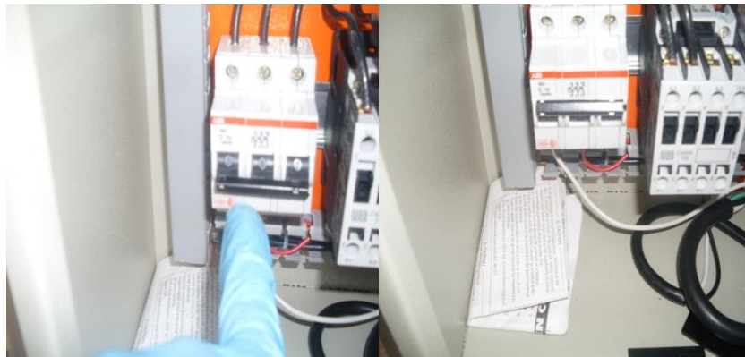
Taco de energía abajo
