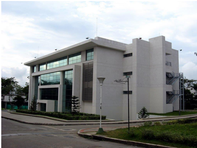
Fachada del Edificio Centic
