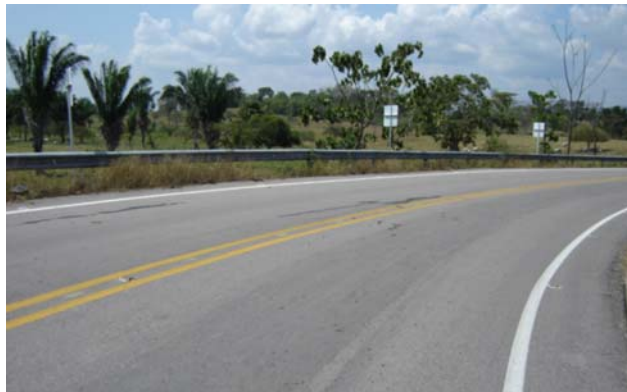
Figura 85. Desgaste superficial.
