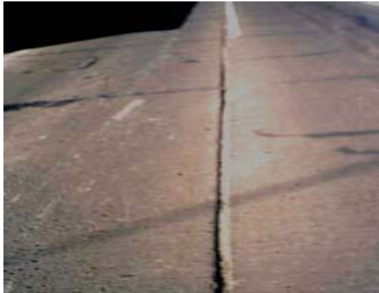
Figura 93. Separación de juntas longitudinales
