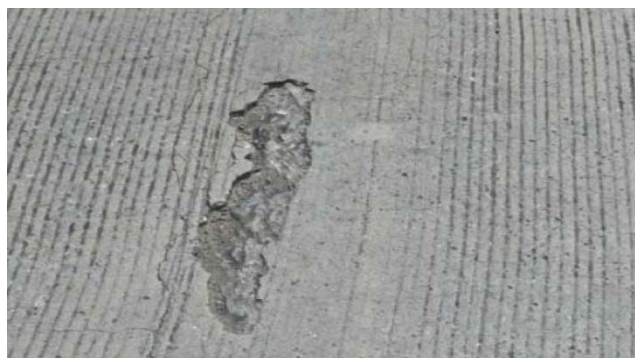
Figura 101. Descascaramiento.
