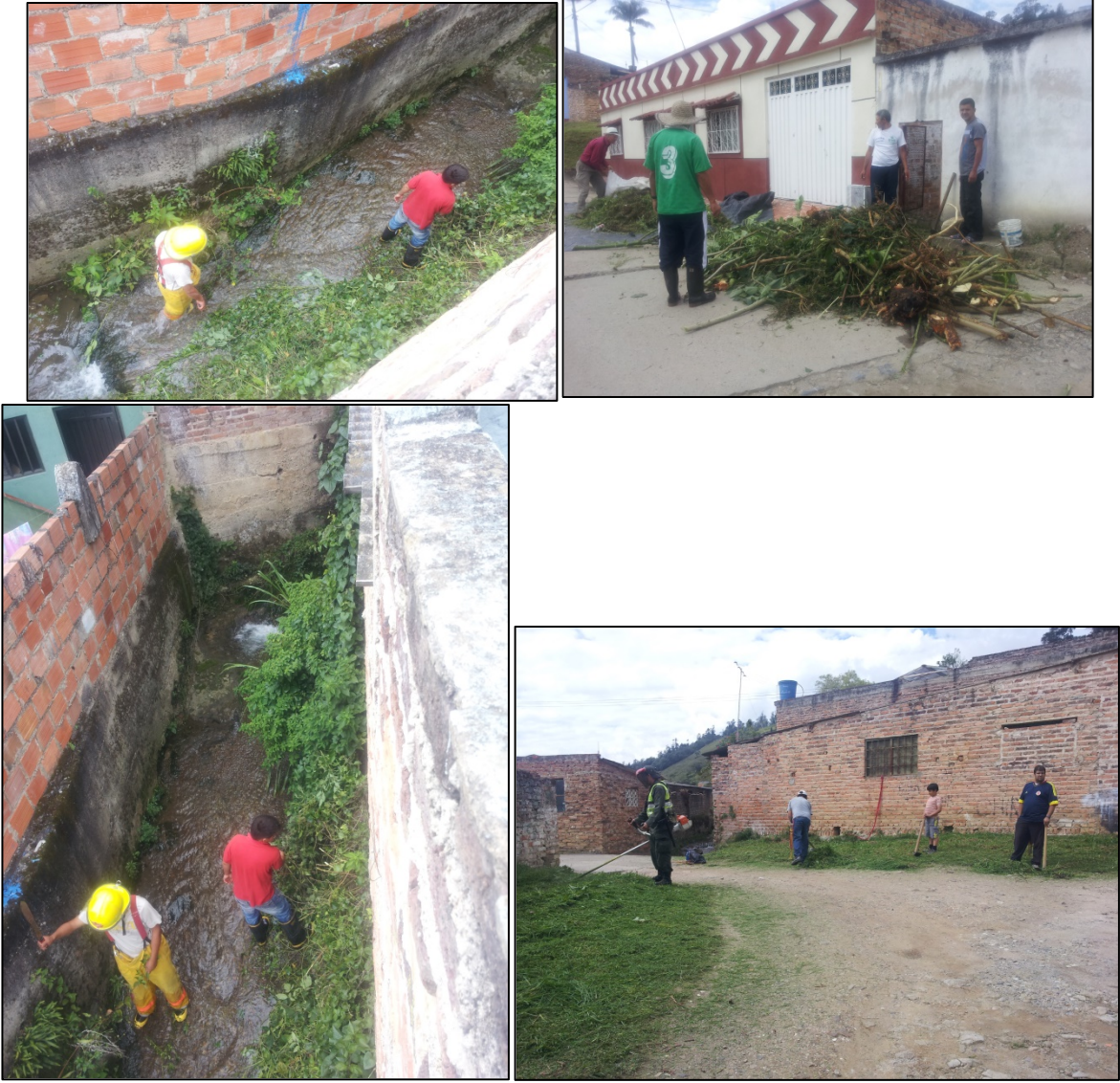
Figura 17. Registro Fotográfico Actividades De Limpieza
