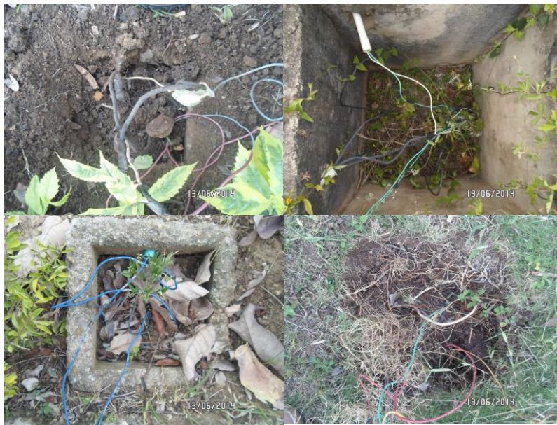
Figura 7 Estado de cámaras de inspección de la red eléctrica de alumbrado público.
