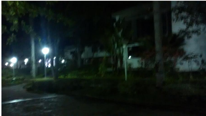
Figura 6 Estado iluminación existente
