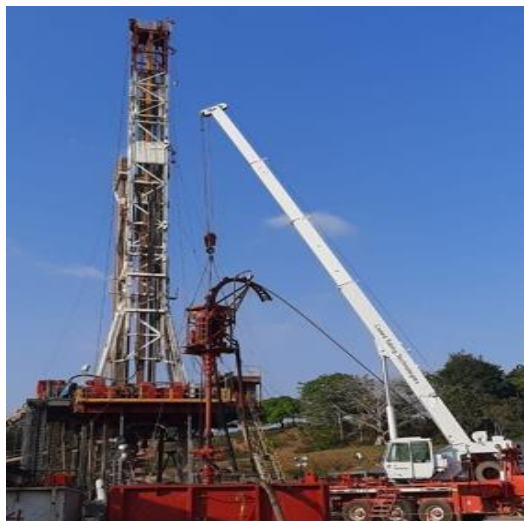
Figura 20. Simops entre Rig y CT
