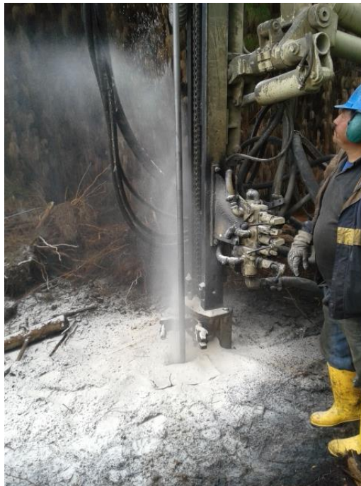
Fotografía 6. Perforación alcanzando el nivel de arenisca.
