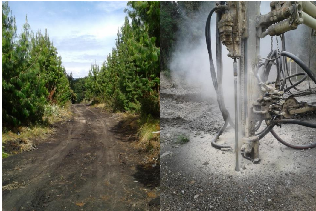
Fotografía 3. Trochas de Acceso tajo 1 norte (Izq.), Perforación alcanzando el techo de la arenisca tajo 1 norte. (Der).
