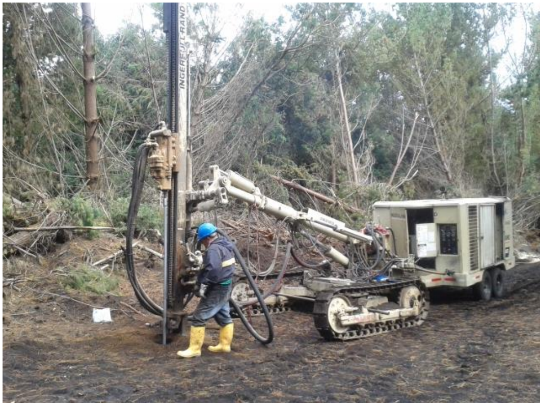
Fotografía 2. Equipo de perforación TRACK DRILL (Nov. 2014).
