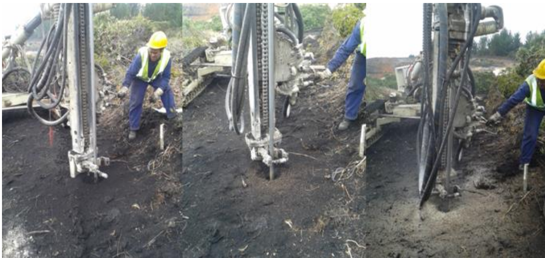
Fotografía 4. Perforación en los 3 horizontes, Suelo, Arcilla, Arenisca.
