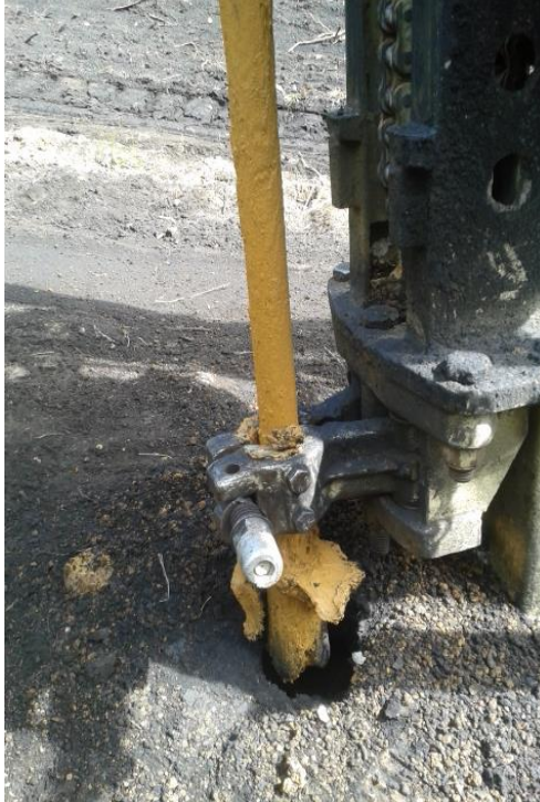
Fotografía 6. Perforación alcanzando el nivel de arenisca.
