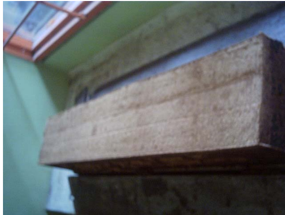
Foto 23. Viga desencofrada
