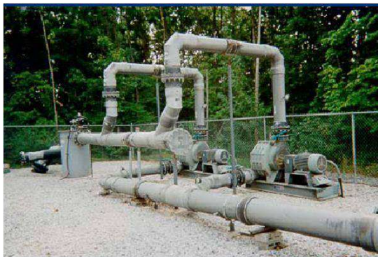
Ilustración 9. Red de aspersión de cada PTAR
