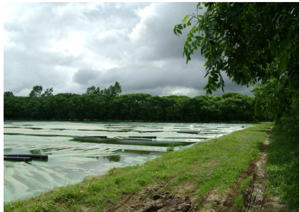
Ilustración 8. Cubierta flotante
