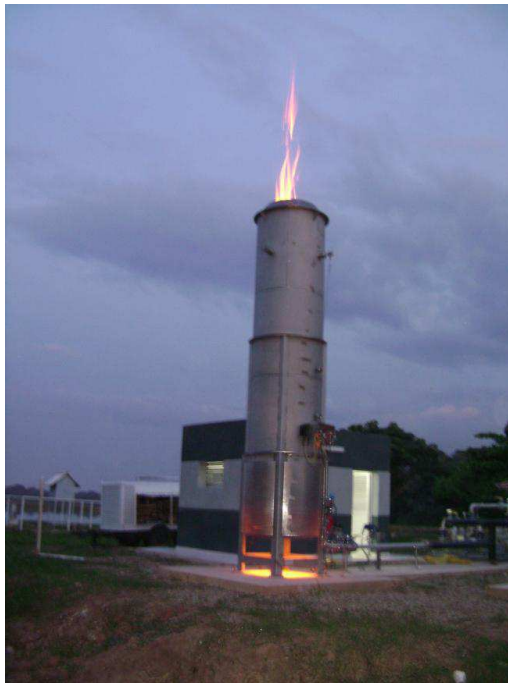
Ilustración 10. Antorcha de alta temperatura
