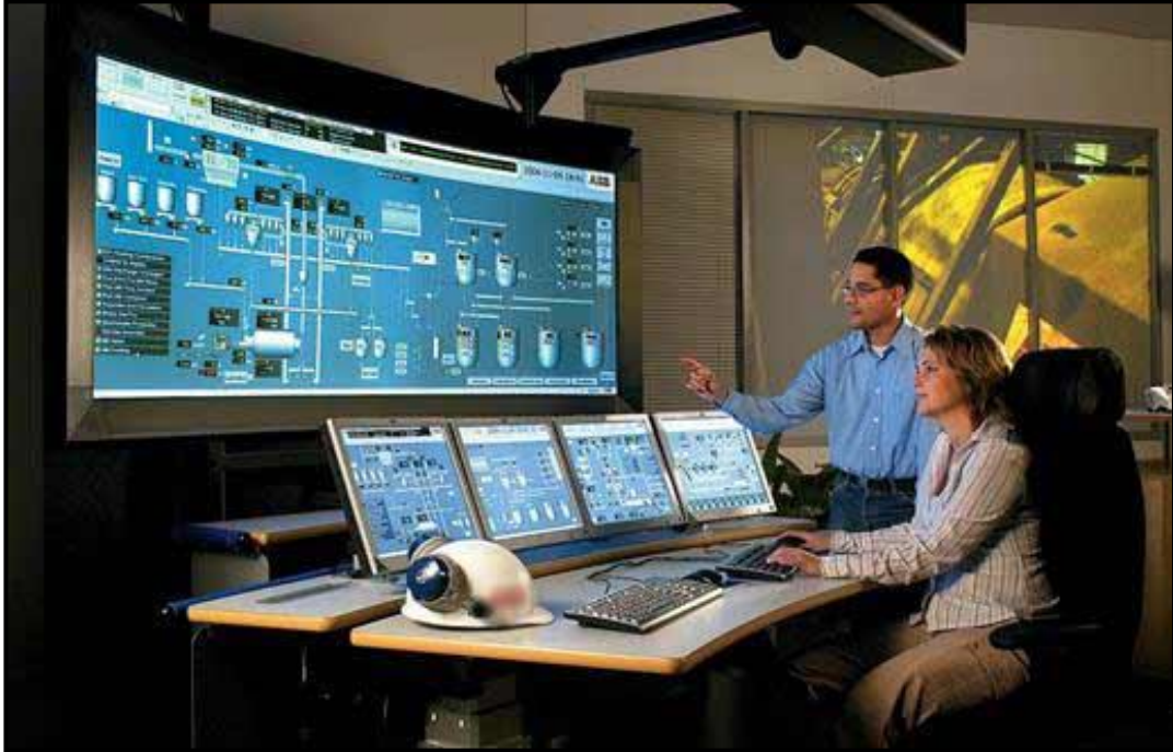
Figura 5. Fotografía de monitoreo mediante el sistema Scada
