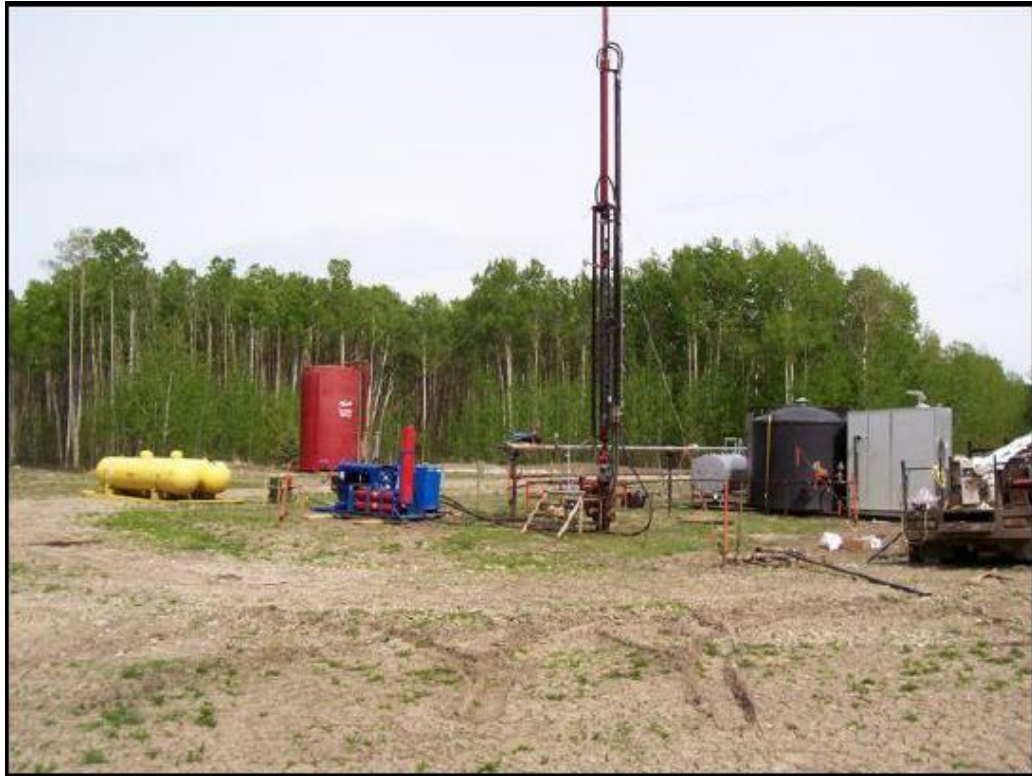
Figura 26. Unidad Bombeo mecánico VSH2.
