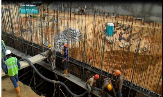
Figura 8. Vaciado del concreto.
