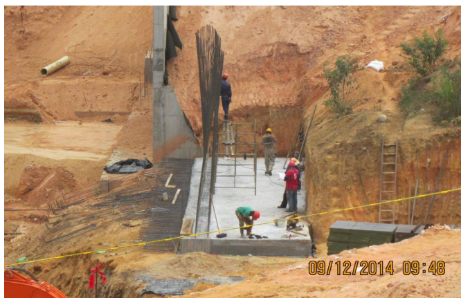
Figura 4. Armado del hierro vertical para el Muro-Zarpa
