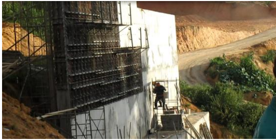
Figura 11. Desencofrado de formaleta.
