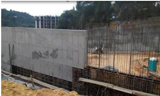
Figura 6. Armado de la formaleta.
