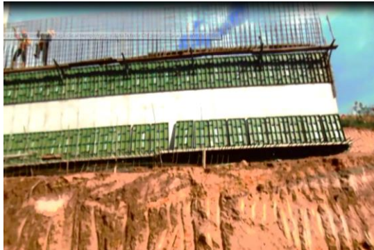
Figura 9. Desencofrado de formaleta.
