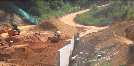
Figura 20. Control de rellenos y movimiento de tierras.
