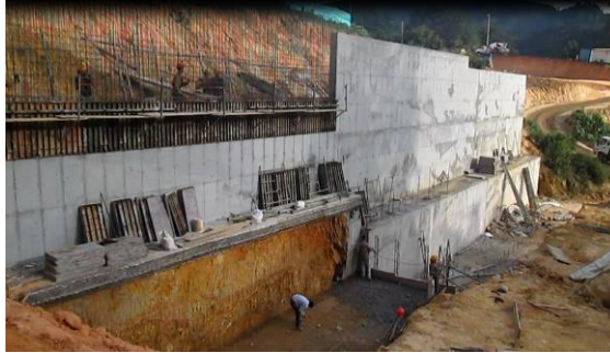
Figura 5. Encofrado y fundida del muro de una zarpa.
