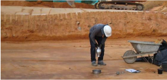
Figura 21. Control de rellenos y movimiento de tierras.
