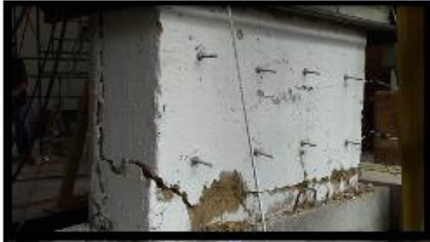
Figura 26. Imagen del Muro en tapia pisada reforzado al finalizar el ensayo
