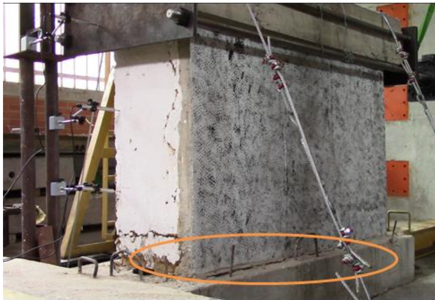
Figura 27. Desprendimiento de base del muro en concreto
