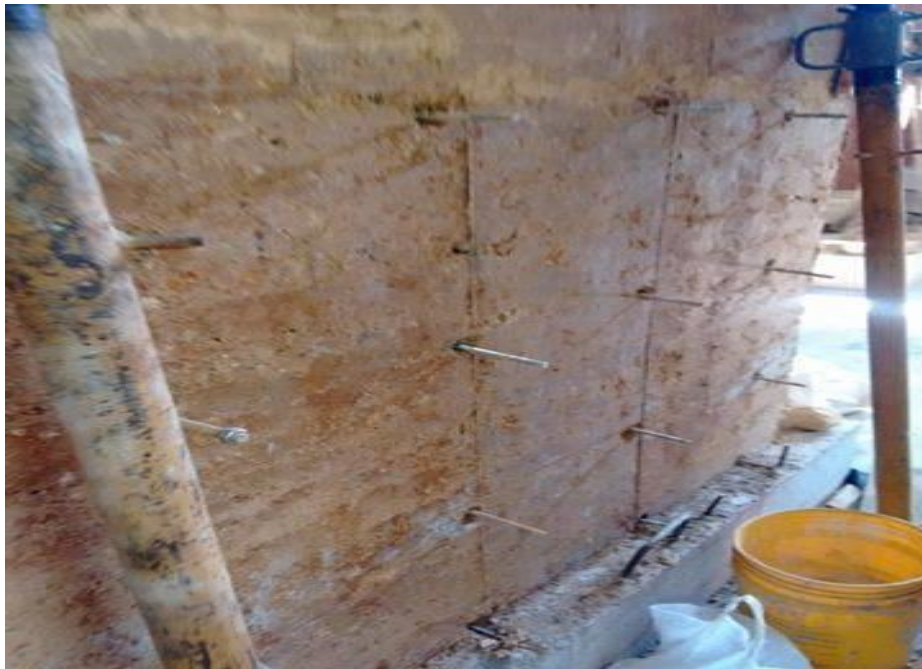
Figura 8. Muro en tapia pisada con tornillos roscados
