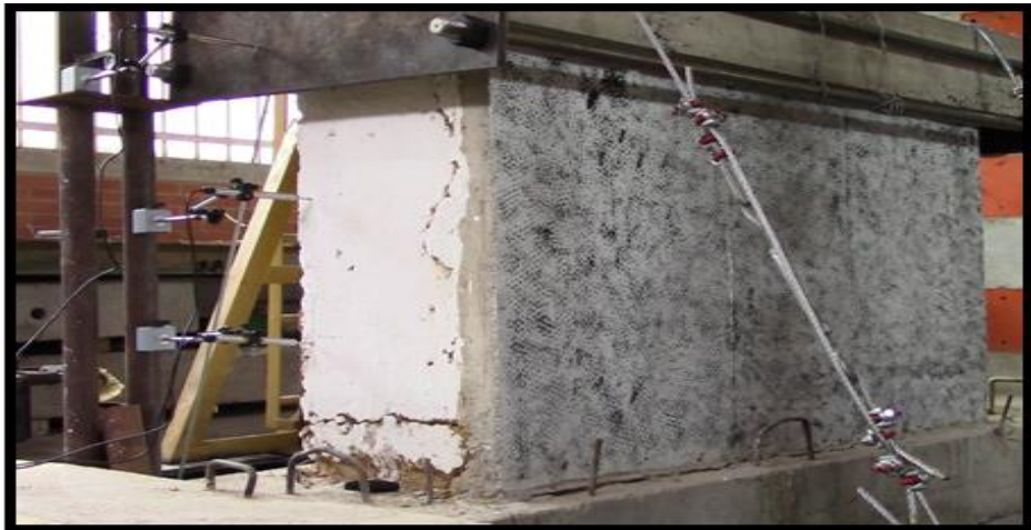
Figura 28. Imagen de extensómetros en el muro en tapia reforzado en alturas de 35, 70 y 105 cm
