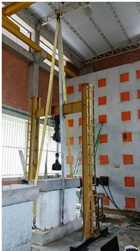
Figura 13. Adecuación del muro típico en tapia pisada usando el puente grúa
