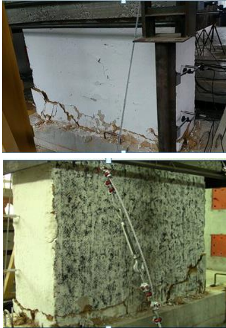
Figura 17. Imagen del muro en tapia pisada al finalizar el ensayo
