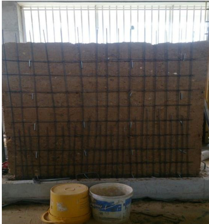
Figura 9. Parrillado del muro en concreto y amarre con los tornillos de anclaje
