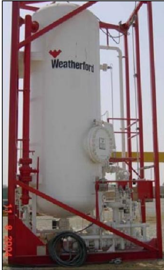
Foto 7. Separador Vertical de Tres Fases
